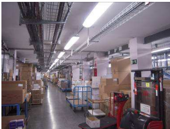
Foto 3: interior del almacén en el sótano del edificio de la Antigua Escuela de Enfermería
