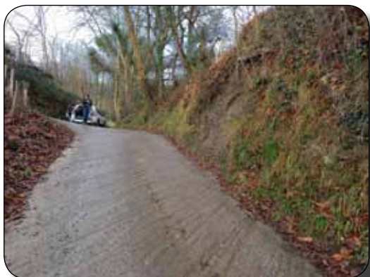
Talud antes de la primera revuelta a la izquierda
