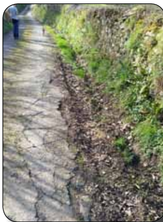
Pavimento dañado junto a la cuneta
