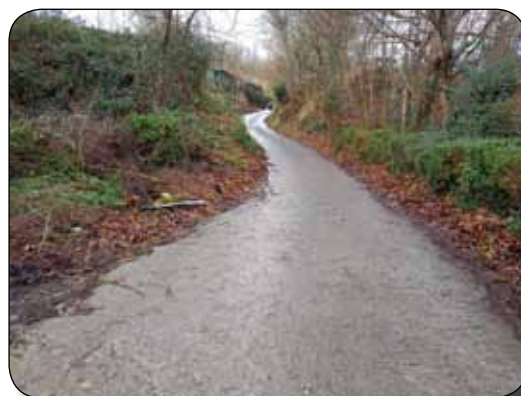
Curva angosta en rampa
