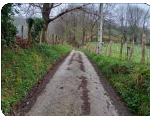
Finalización a la altura del poste, ya sin pendiente
