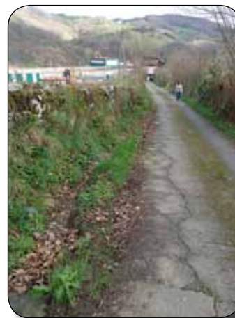
Pavimento dañado junto a la cuneta
