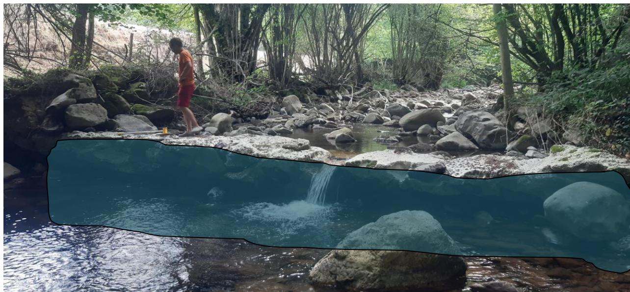
Construcción de escollera
