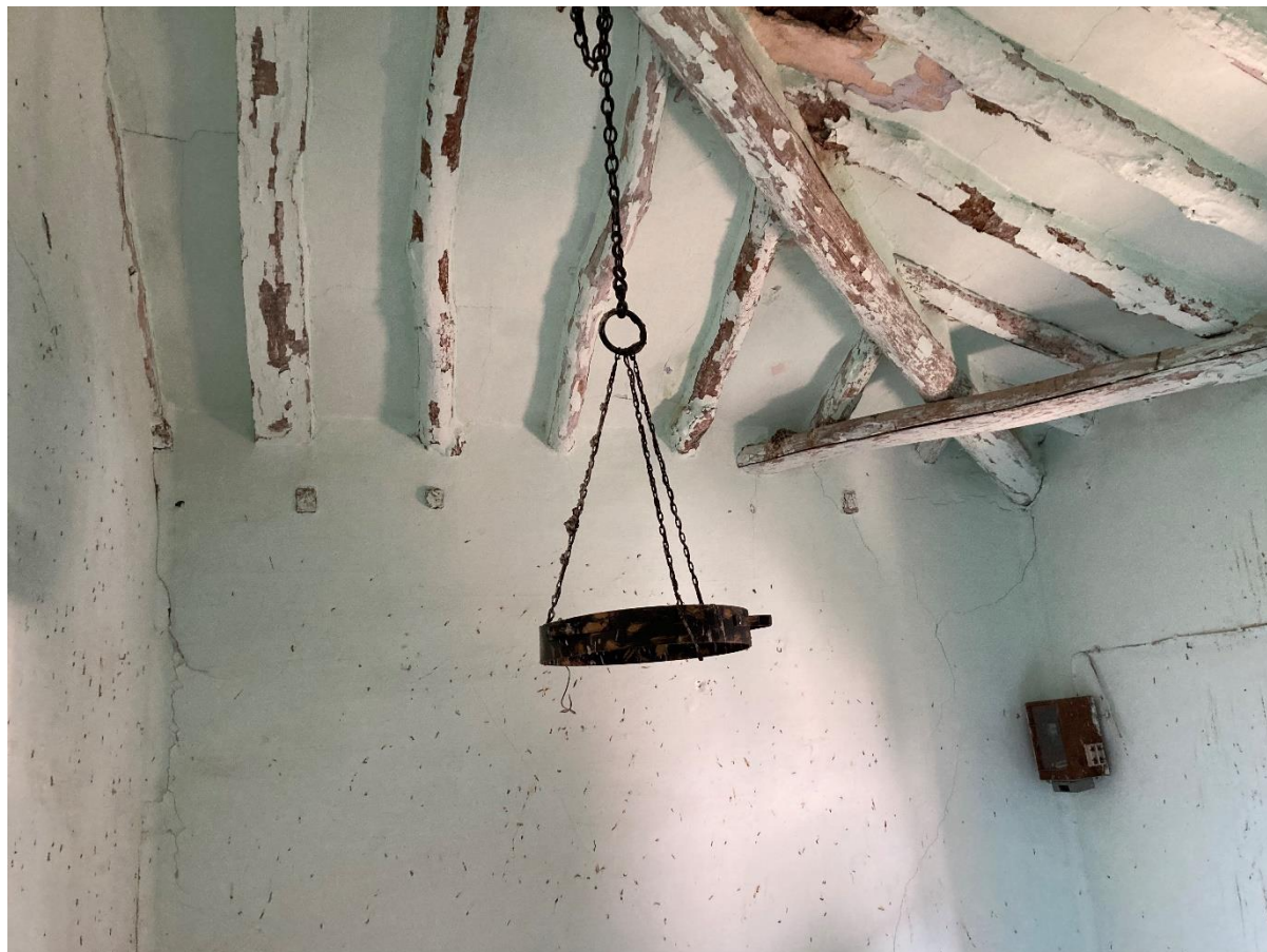
Vista de la estructura de cubierta
