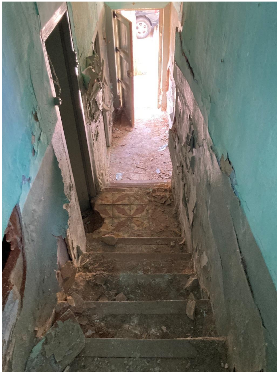
Vista de la escalera desde el rellano
