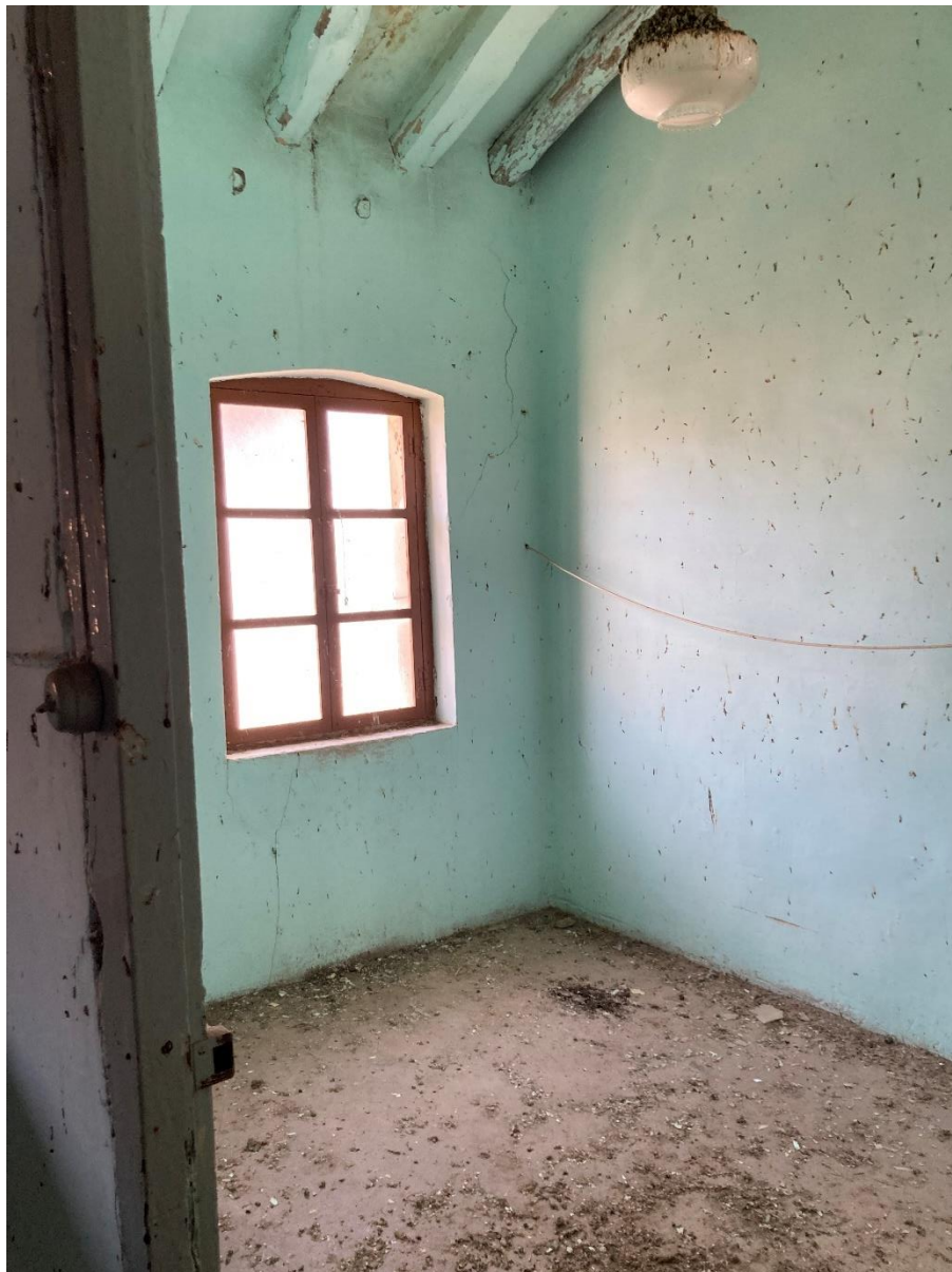
Vista de habitación de planta primera
