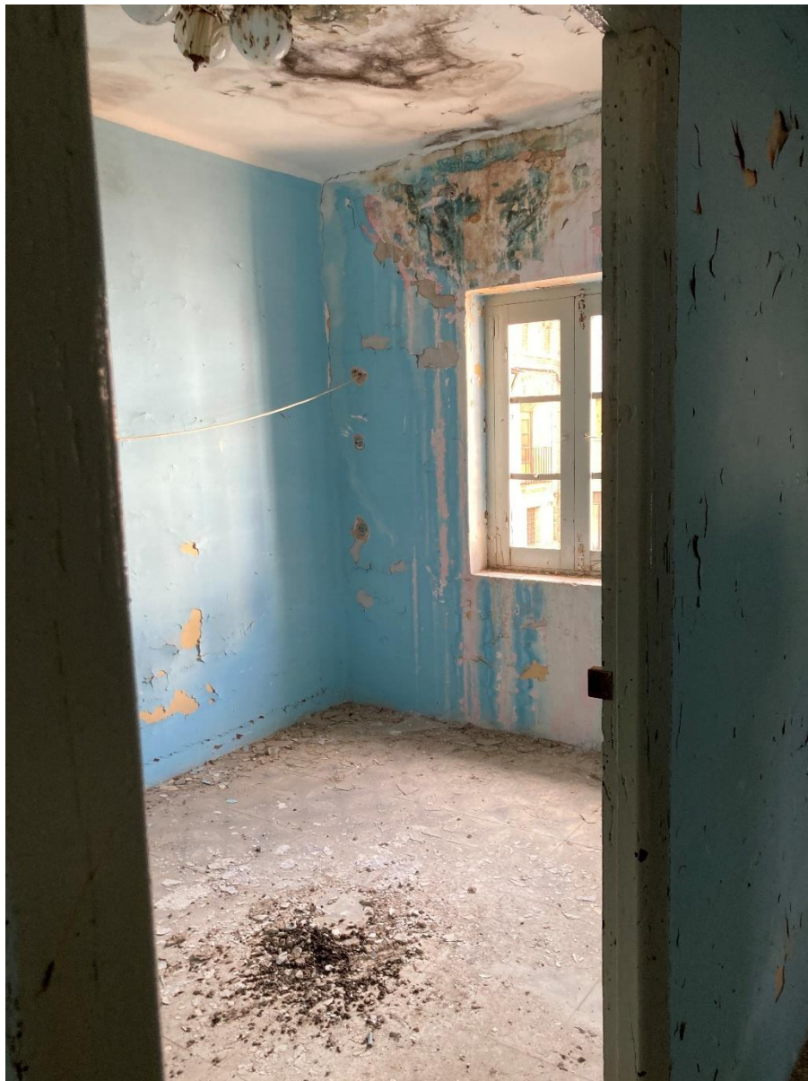
Vista de habitación de planta primera
