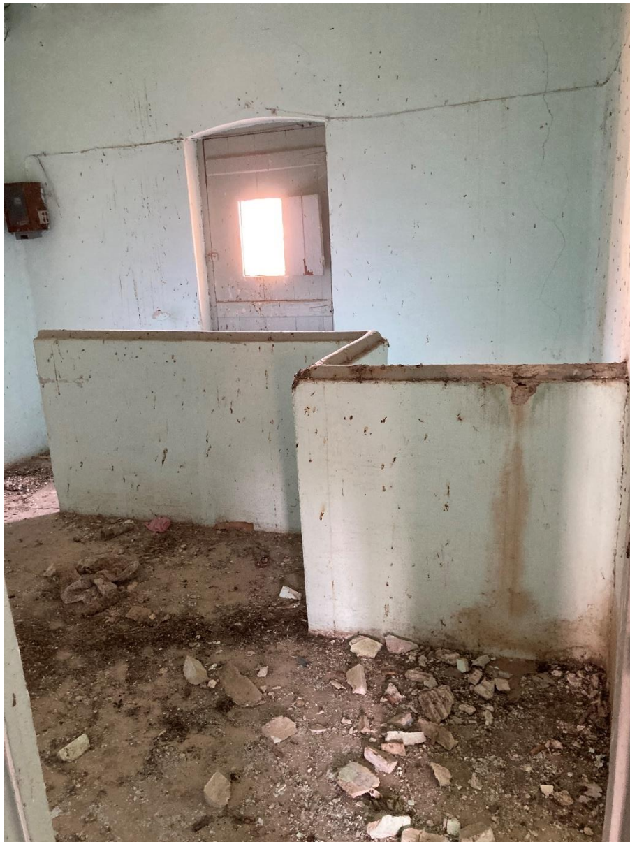
Vista del antepecho del hueco de escalera
