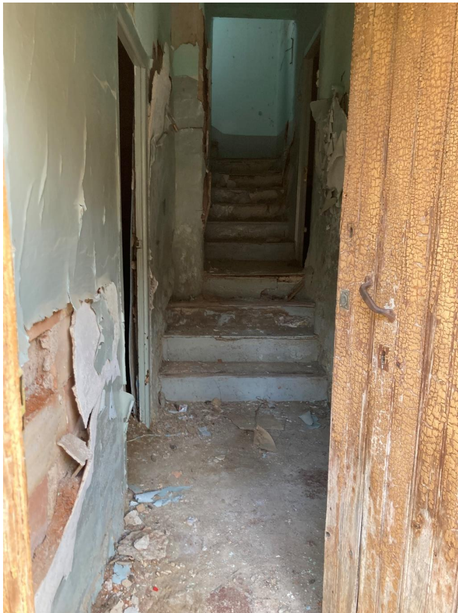
Vista de la escalera desde el acceso
