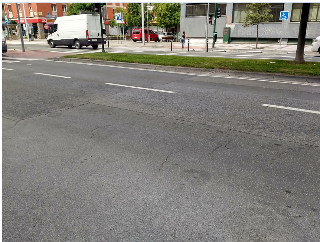
Estado actual de la Avenida una vez pasado el primer semáforo
