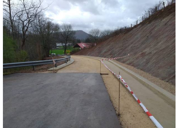
Figura 5: Extendido de base
