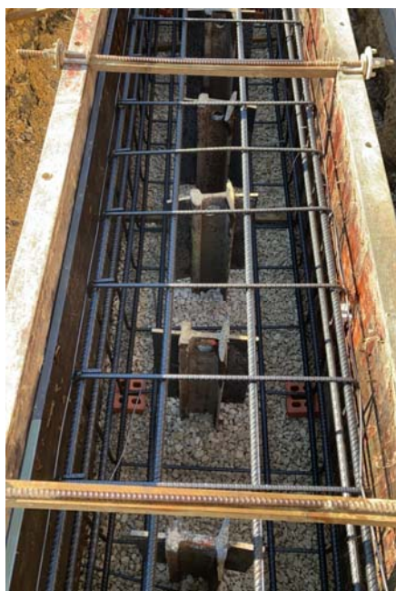
Figura 2: Encofrado de viga de coronación
