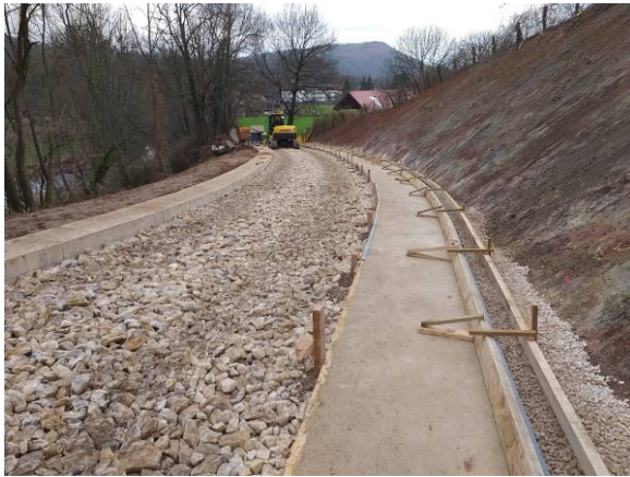
Figura 4: Extendido de base y cuneta
