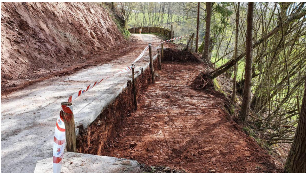
Fotografía tomada durante la ejecución de las obras para la construcción del muro de pantalla en camino Artxeko Borda
