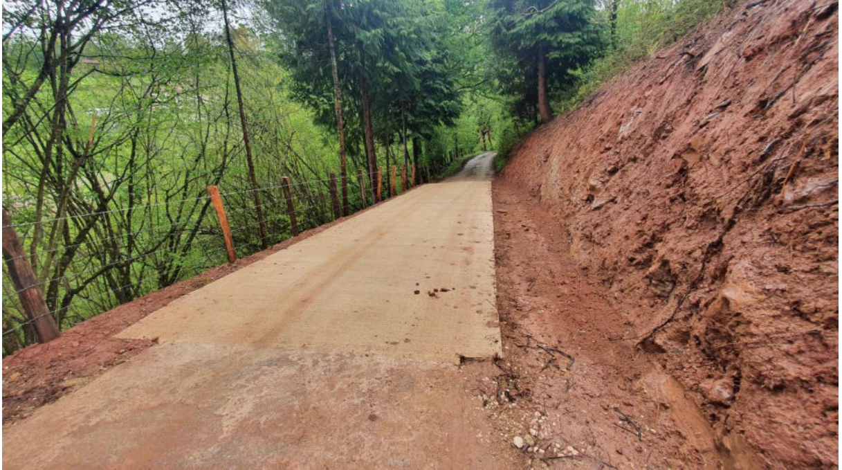
Fotografía tomada una vez acabadas las actuaciones en camino Artxeko Borda.
