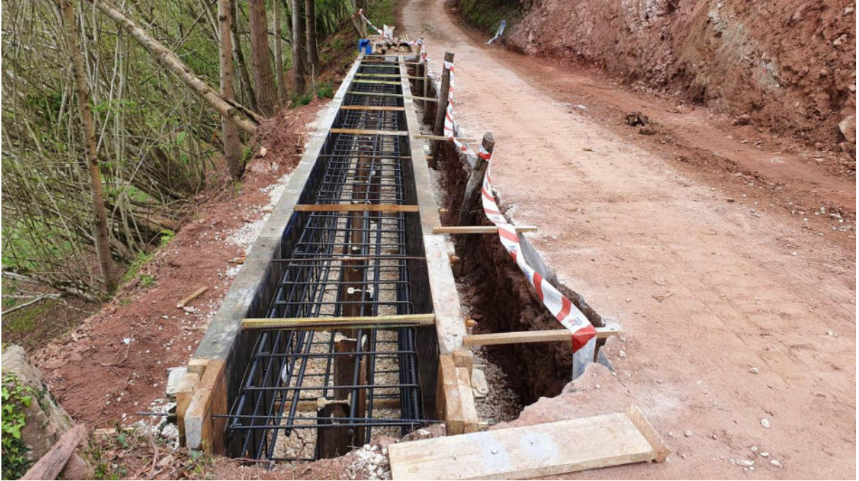
Otra fotografía tomada durante la ejecución de las obras para la construcción del muro de pantalla en camino Artxeko Borda. Armadura de la viga
