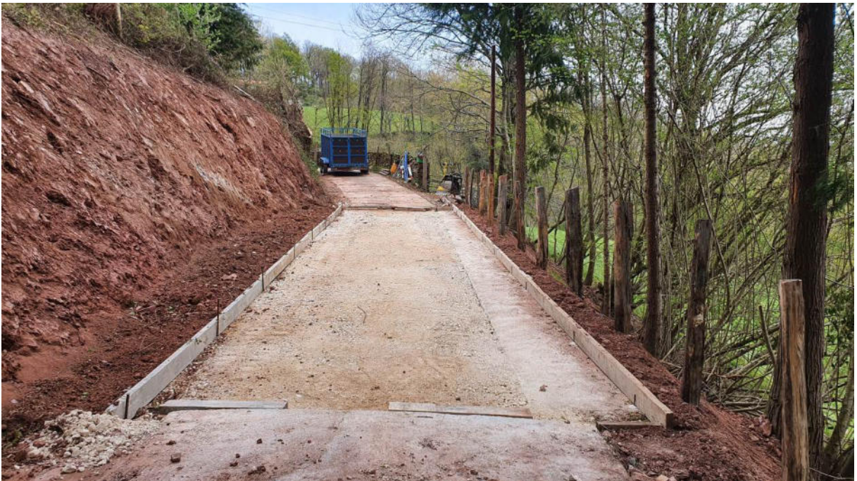
Fotografía tomada durante la ejecución de las obras para la construcción del muro de pantalla en camino Artxeko Borda. Afirmado con zahorras antes del pavimento de hormigón
