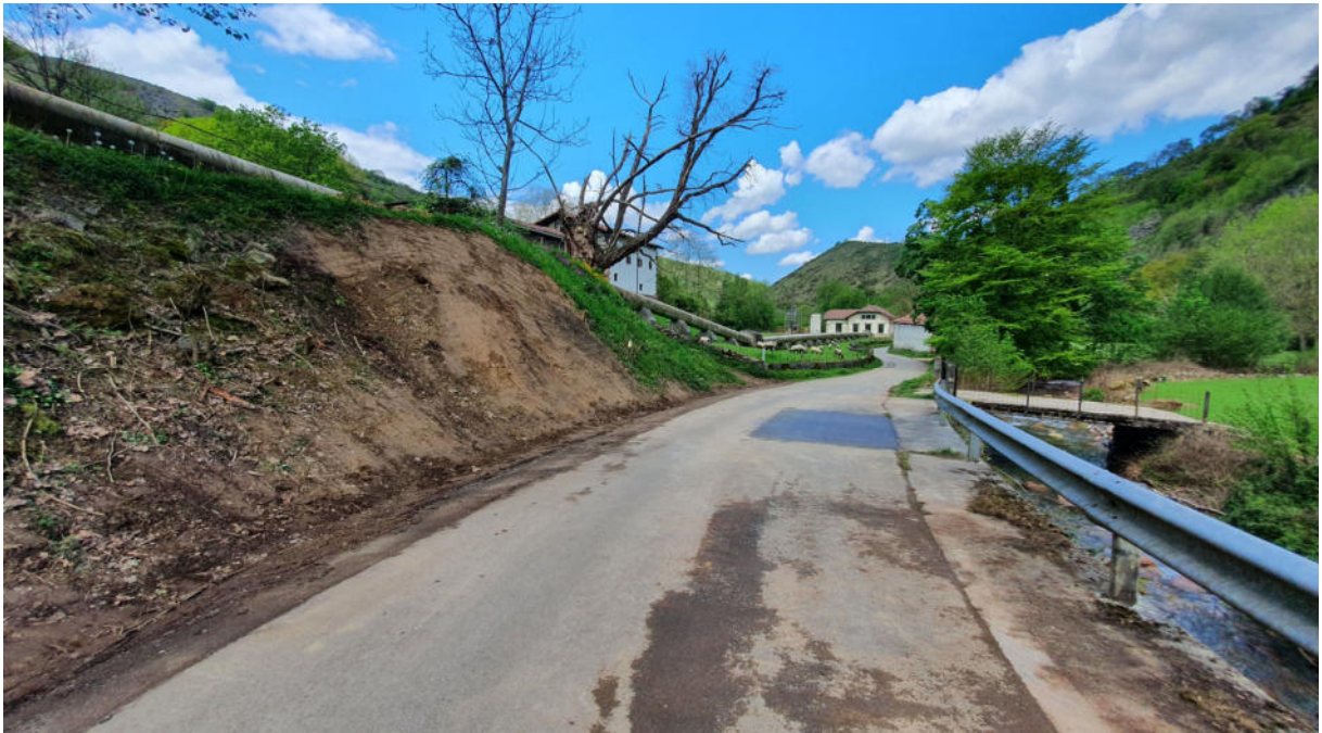
Fotografía tomada una vez acabadas las actuaciones de reparación en camino Arbuz
