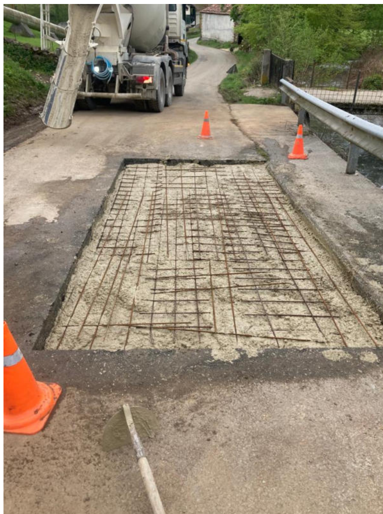
Otra fotografía tomada durante la ejecución de las obras de reparación en camino Arbuz
