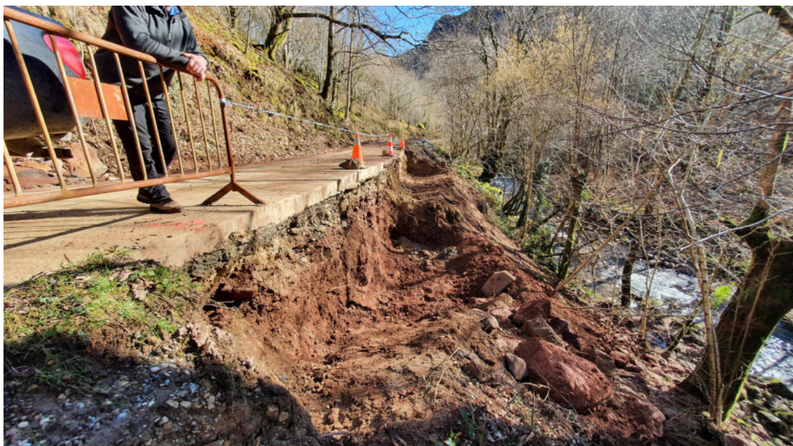
Fotografía tomada durante la ejecución de las obras de muro de escollera en el camino Aritzakungo Bidea2
