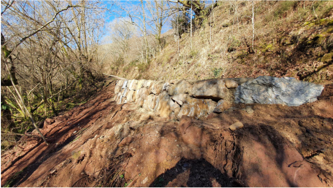
Fotografía tomada durante la ejecución de las obras con el de muro de escollera a medias en el camino Aritzakungo Bidea2
