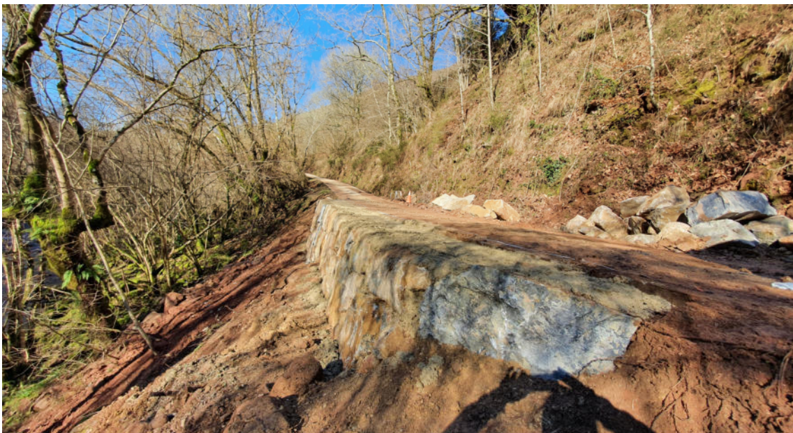
Fotografía tomada una vez terminadas las obras de reparación en el camino Aritzakungo Bidea2.
