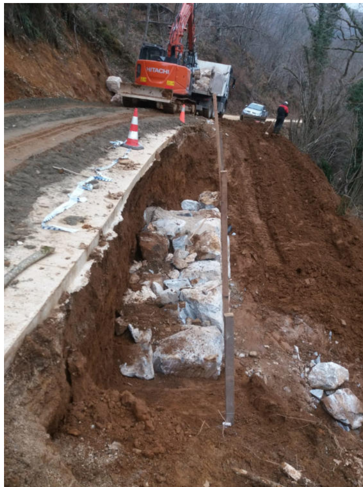
Fotografía tomada durante la ejecución de las obras de muro de escollera en el camino Aritzakungo Bidea1
