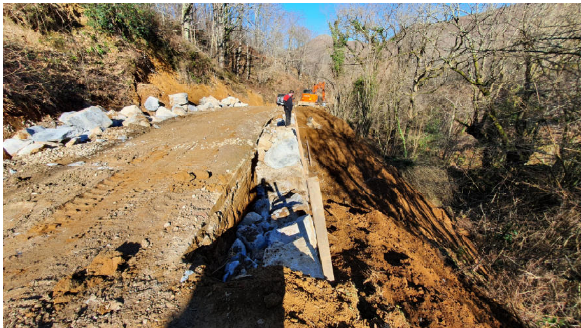
Fotografía tomada durante la ejecución de las obras con el de muro de escollera a medias en el camino Aritzakungo Bidea1
