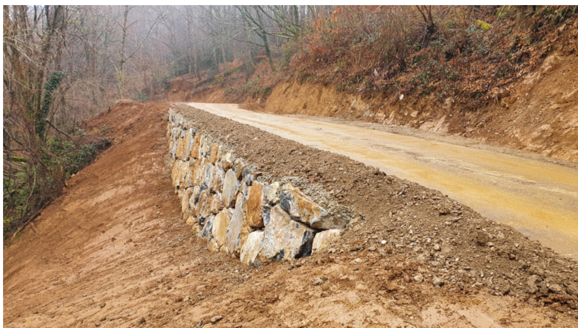
Fotografía tomada una vez terminadas las obras de reparación en el camino Aritzakungo Bidea1.
