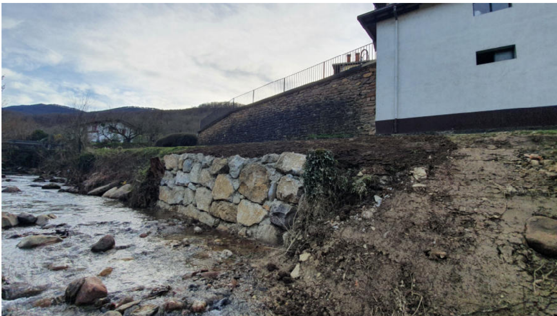
Fotografía tomada una vez terminadas las obras de reparación en el camino Arbuz.
