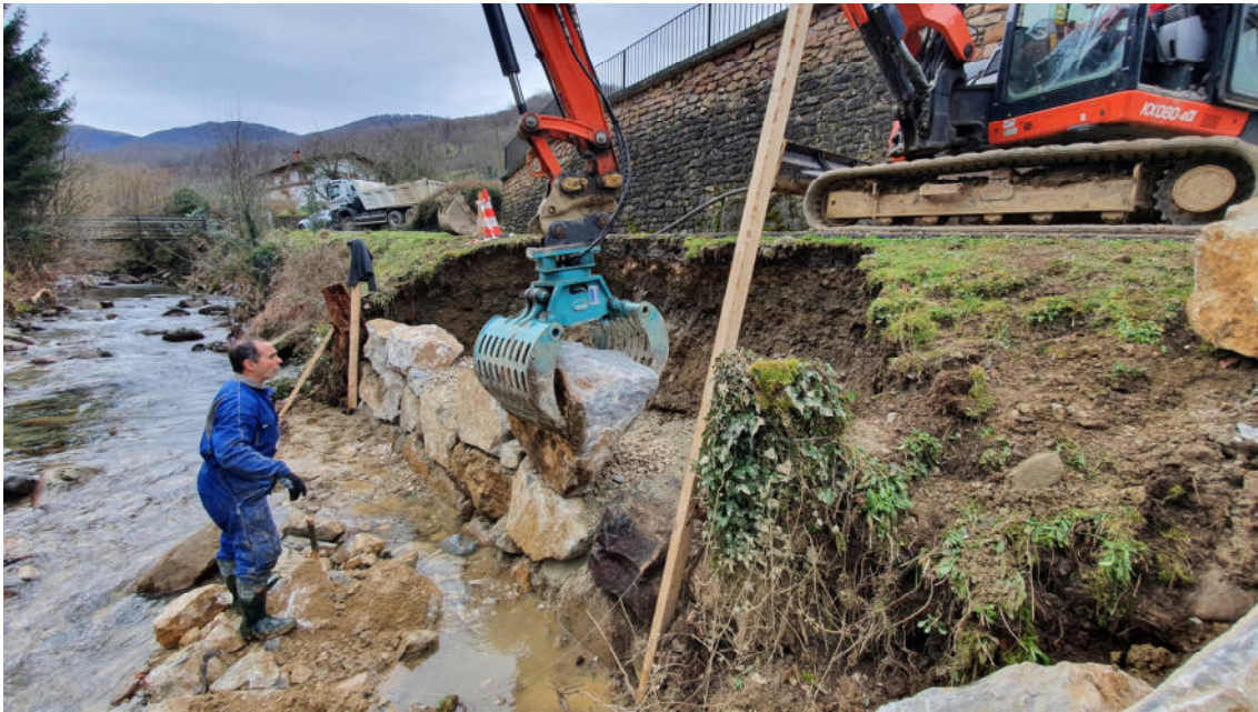
Fotografía tomada durante la ejecución de las obras con el de muro de escollera a medias en el camino de Arbuz
