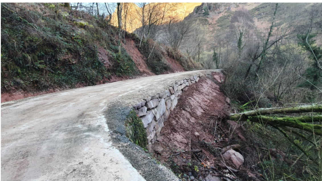
Fotografía tomada una vez terminadas las obras de reparación en el camino Aritzakungo Bidea.
