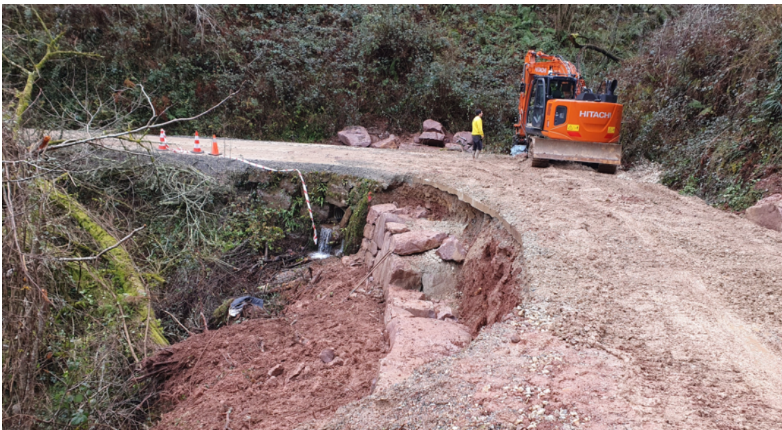
Fotografía tomada durante la ejecución de las obras con el de muro de escollera a medias en el camino Aritzakungo Bidea
