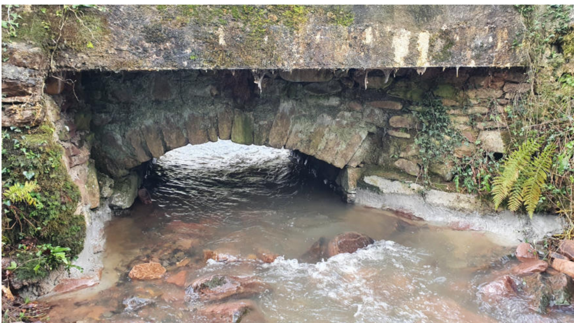
Fotografía tomada una vez terminadas las obras de reparación en el puente del camino a Bixtaeder aguas abajo
