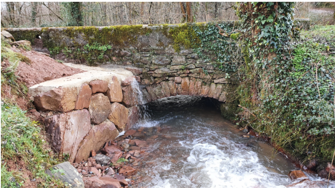
Fotografía tomada una vez terminadas las obras de reparación en el puente del camino a Bixtaeder aguas arriba
