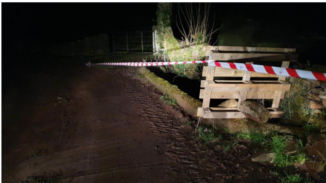
Fotografía tomada durante antes ejecución de las obras de reparación en el puente del camino a Bixtaeder
