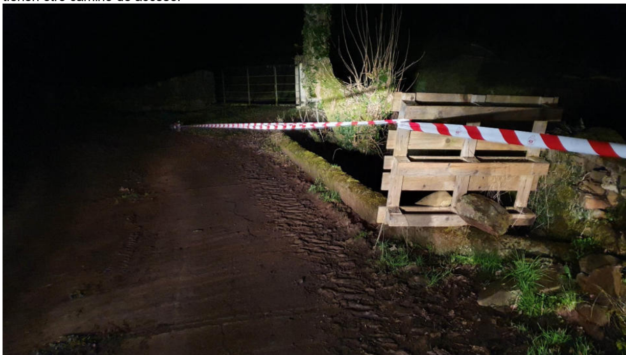
Fotografía del puente del camino señalizado de Bixtaeder
