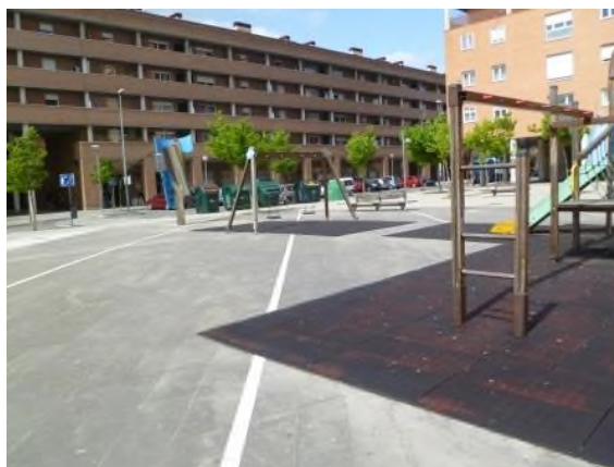
Zona balancines a cambiar el suelo
