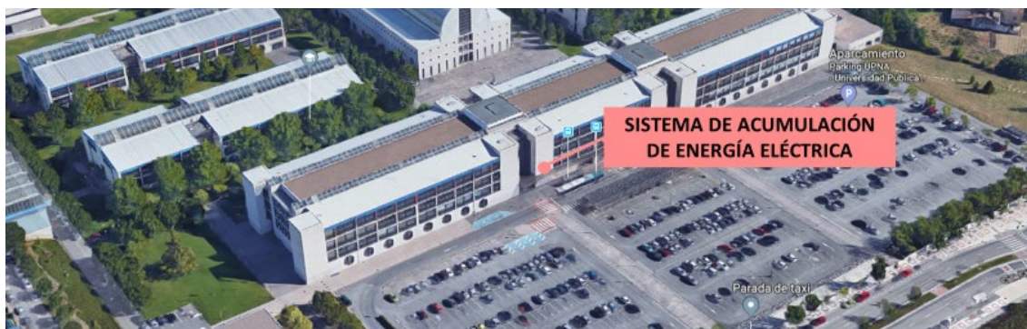
Figura 1. Localización del sistema de acumulación de energía eléctrica.
