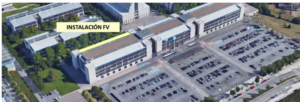
Figura 2. Localización del campo fotovoltaico.
