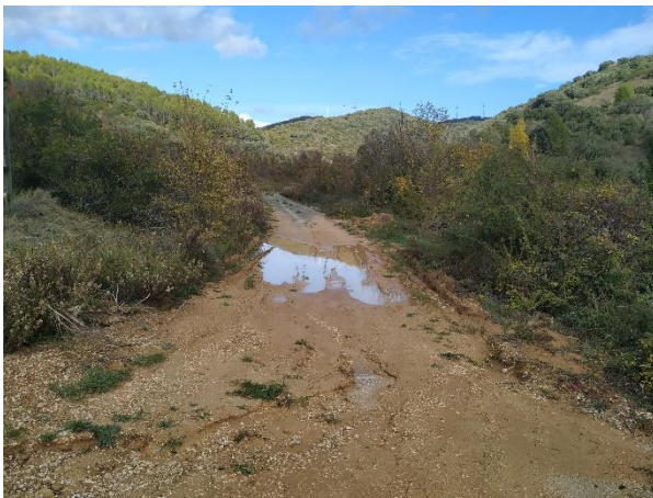
CAMINO 28 – Rodadas marcadas, baches, acumulación de material de arrastre.
