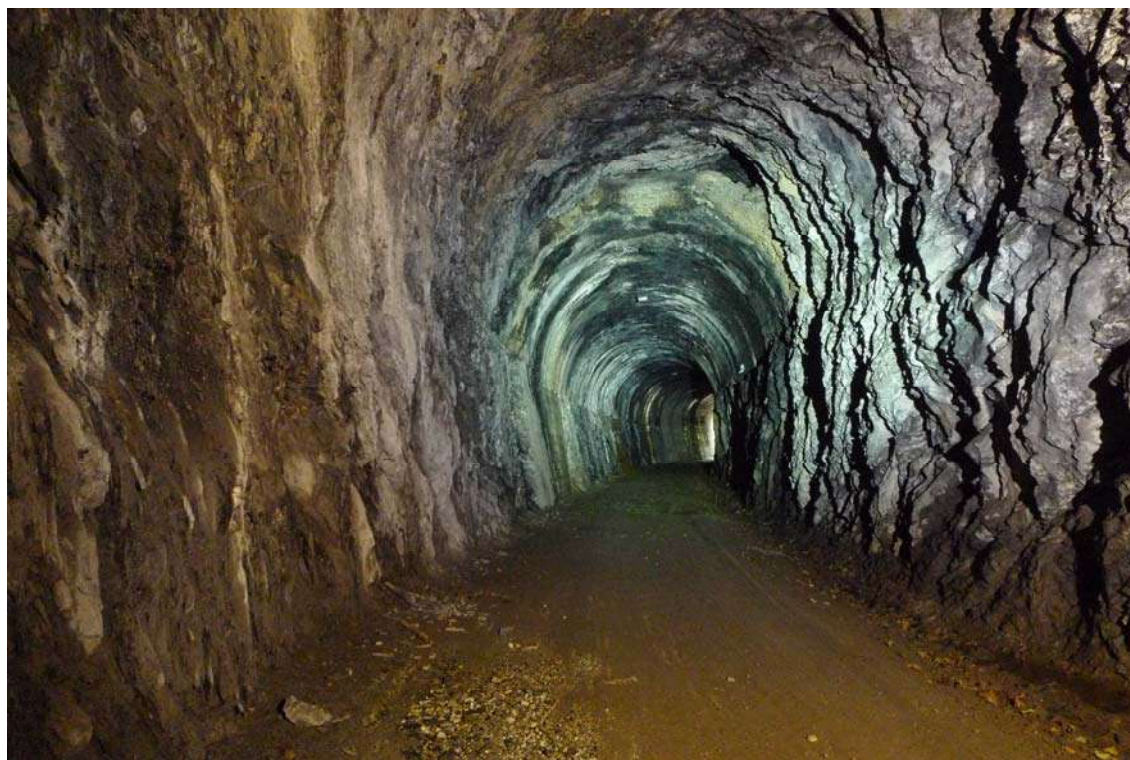
Aspecto zona central del túnel ST3
