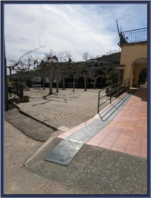
FOTOGRAFÍA 1: ESTADO INICIAL DE LA PLAZA DESDE PARTE INFERIOR DE LA CALLE MAYOR
