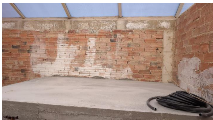
Fotografía 7: Zona de colocación de las unidades exteriores en cubierta
