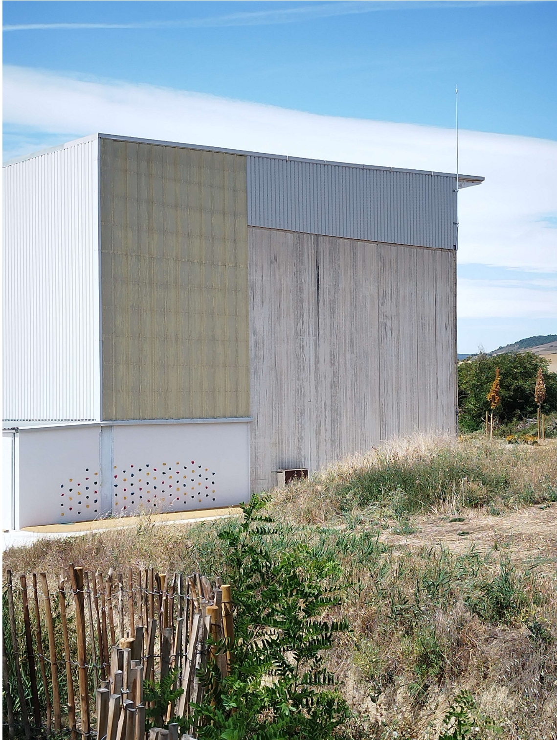
Pared exterior del frontis de Salinas de Ibarroiti. La actuación se desarrollaría sobre la zona hormigonada.
