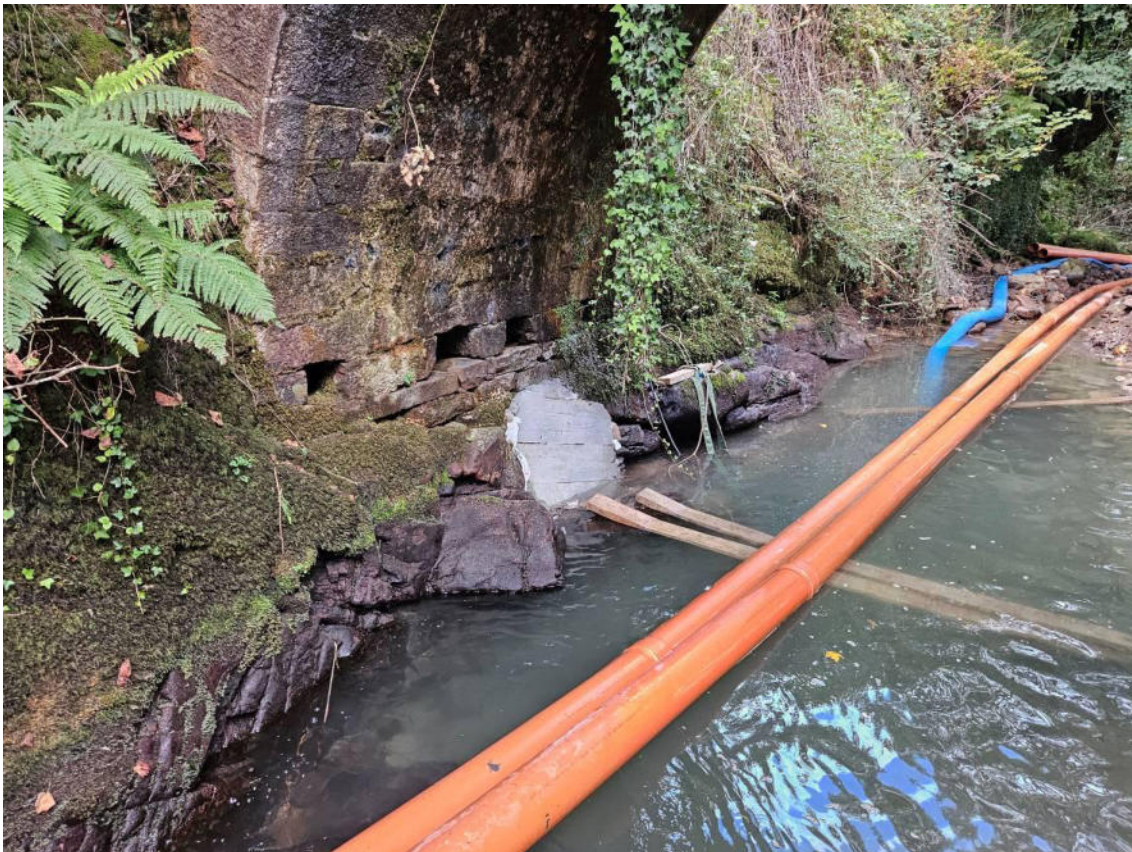
Otra fotografía tras el desencofrado del hormigón y durante la retirada del sistema de drenaje. Margen izquierda.
