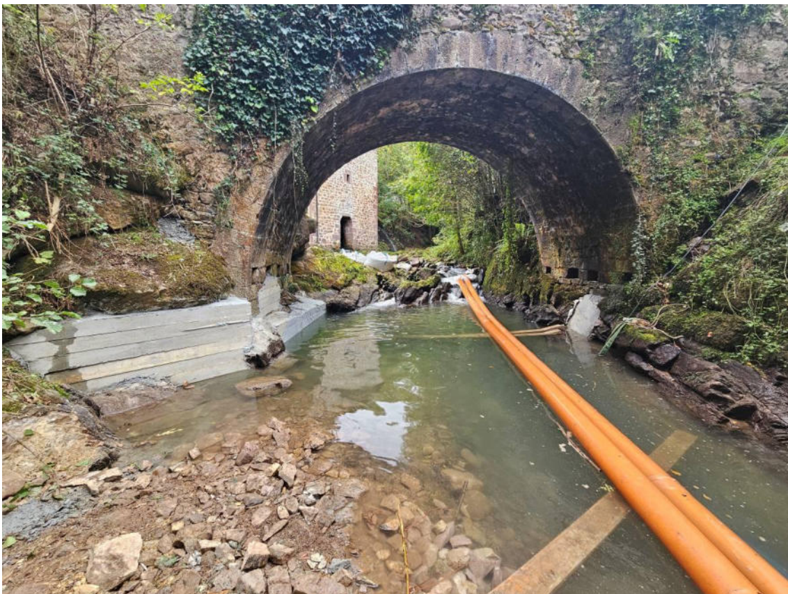
Fotografía tras el desencofrado del hormigón y durante la retirada del sistema de drenaje
