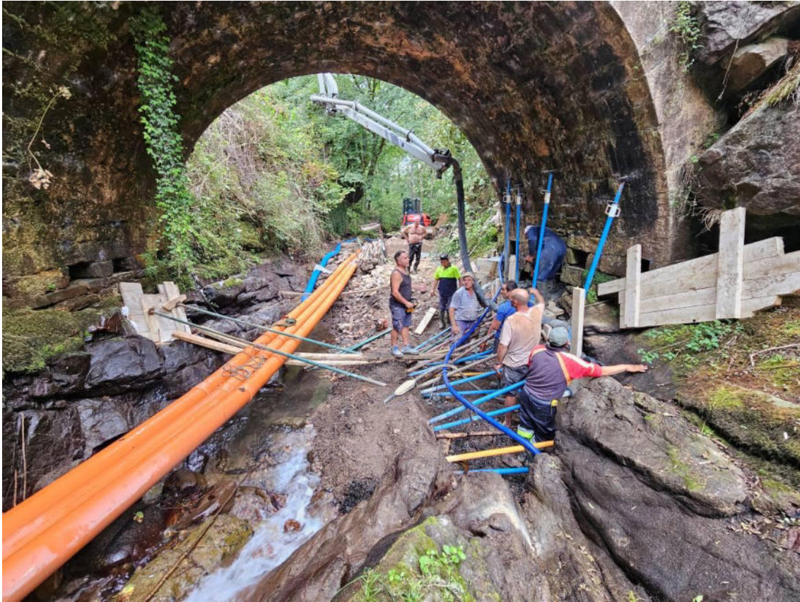
Fotografía del vertido de hormigón mediante camión provisto de bomba para hormigón
