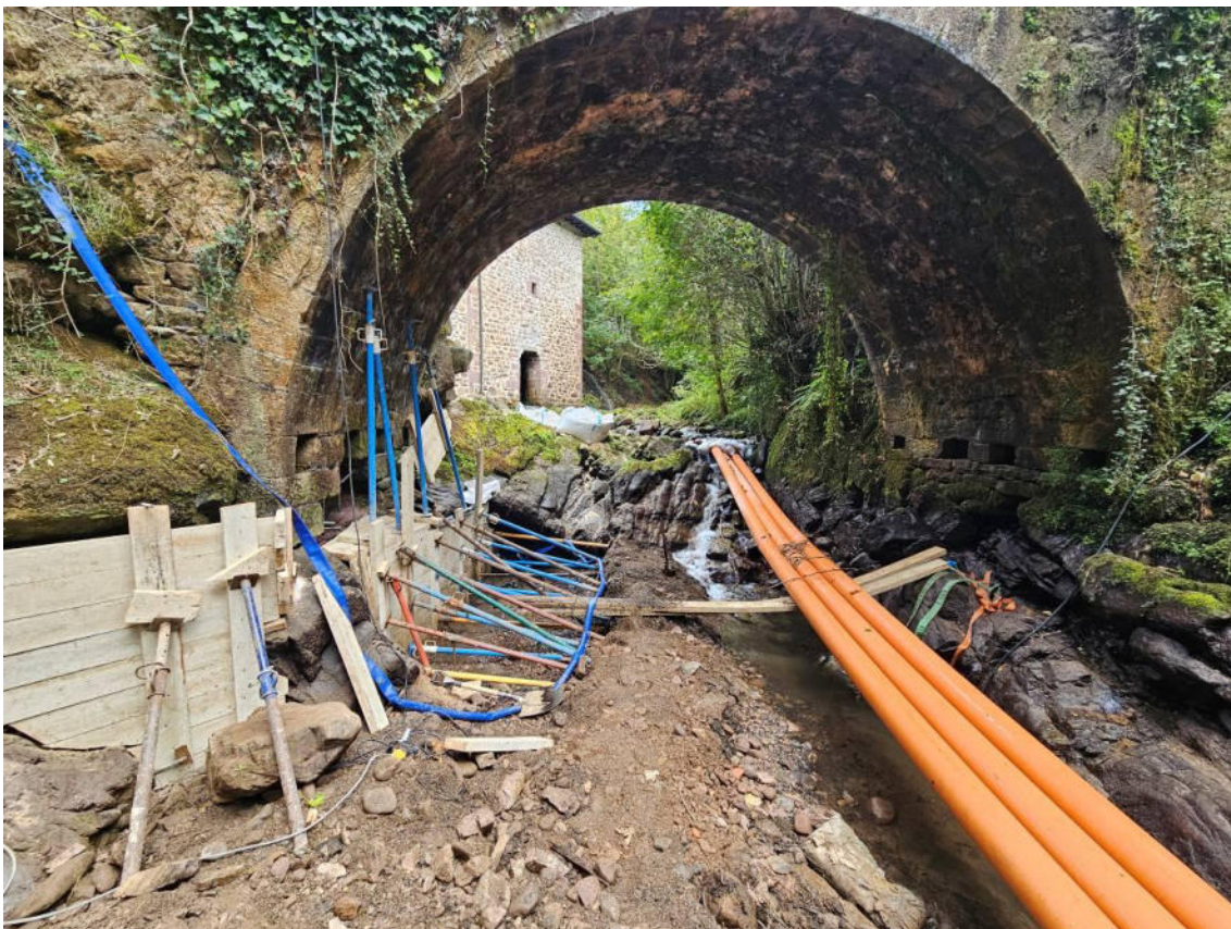
Otra fotografía del encofrado realizado para el hormigón en el Puente Etxaideko Errota
