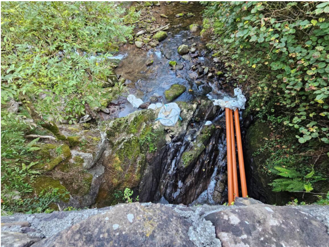
Otra fotografía del sistema de tubos de PVC y sacos de arena utilizado para desviar el agua desde aguas arriba del puente hasta aguas abajo
