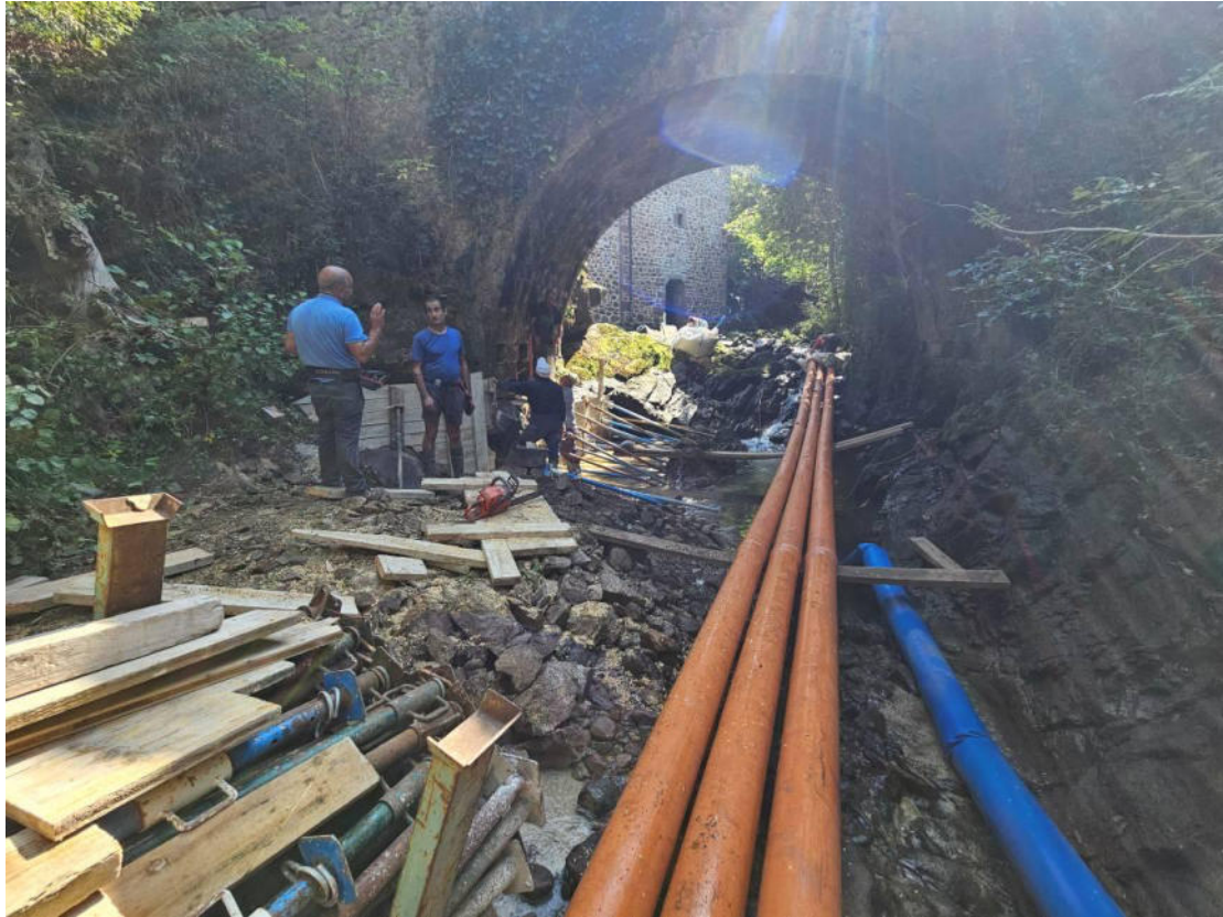
Fotografía del sistema de tubos de PVC y sacos de arena utilizado para desviar el agua desde aguas arriba del puente hasta aguas abajo
