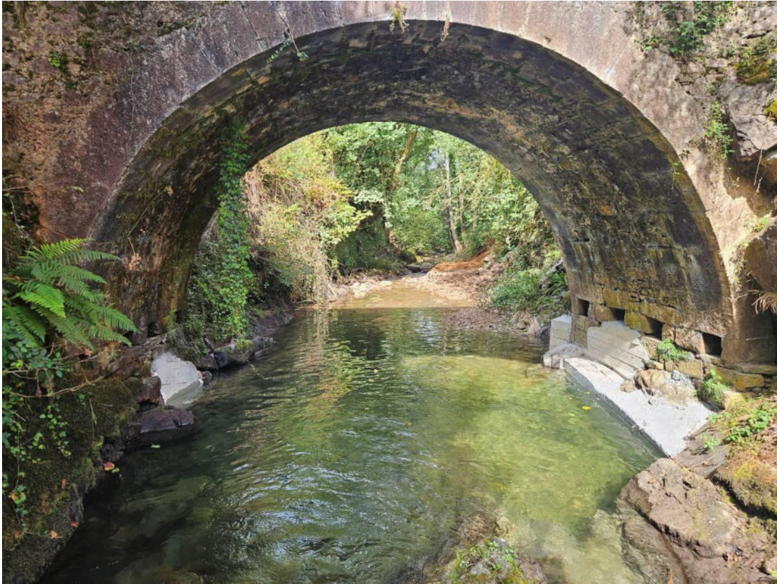
Fotografía una vez realizada la reparación y la retirada completa del sistema de drenaje
