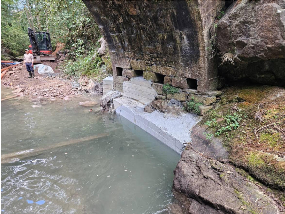
Otra fotografía tras el desencofrado del hormigón y durante la retirada del sistema de drenaje. Margen derecha.
