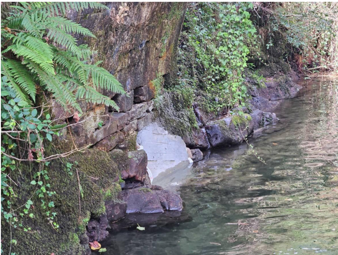
Fotografía de la margen izquierda del río, una vez finalizada la obra.
