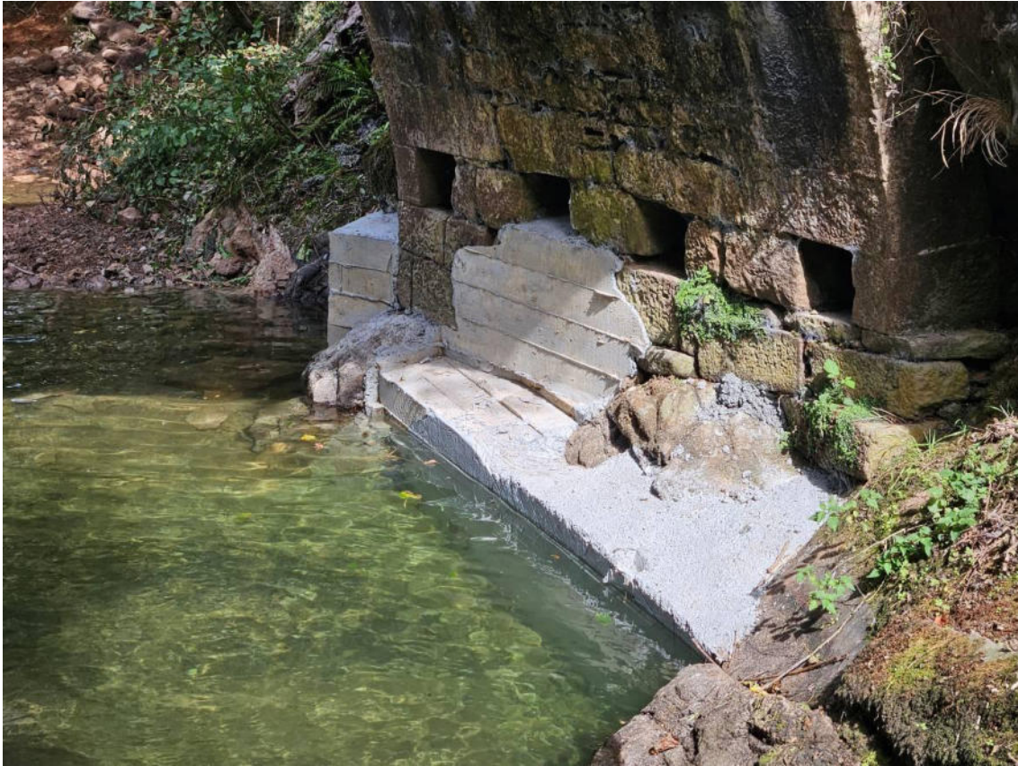
Fotografía de la margen derecha del río, una vez finalizada la obra.
