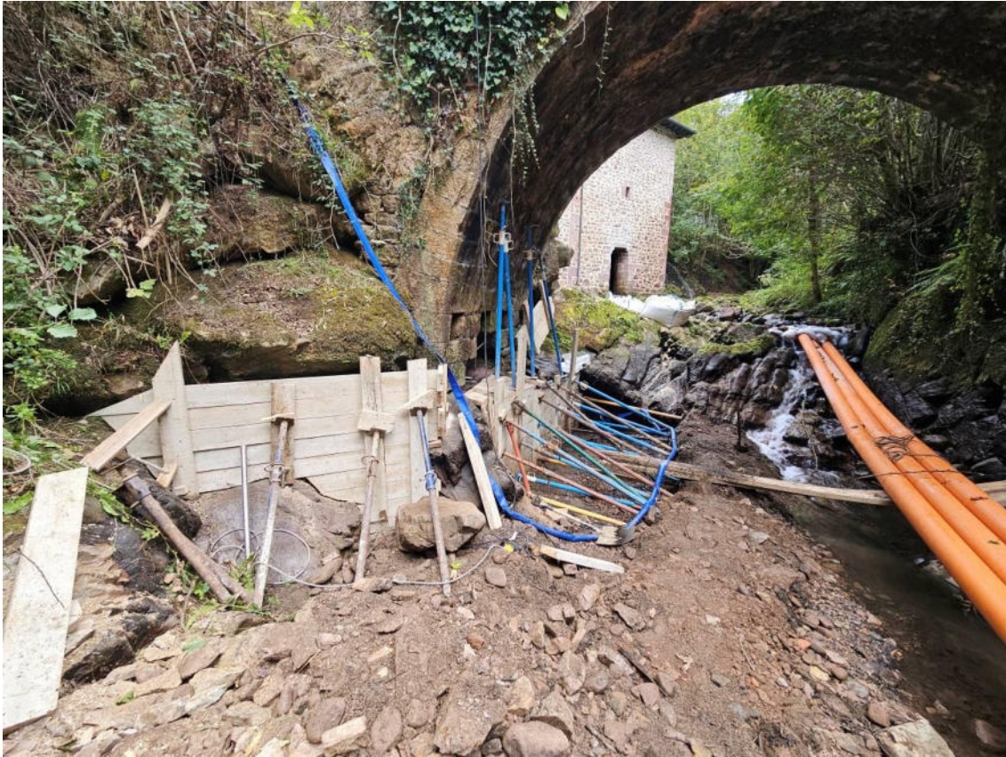
Fotografía del encofrado realizado para el hormigón en el Puente Etxaideko Errota
