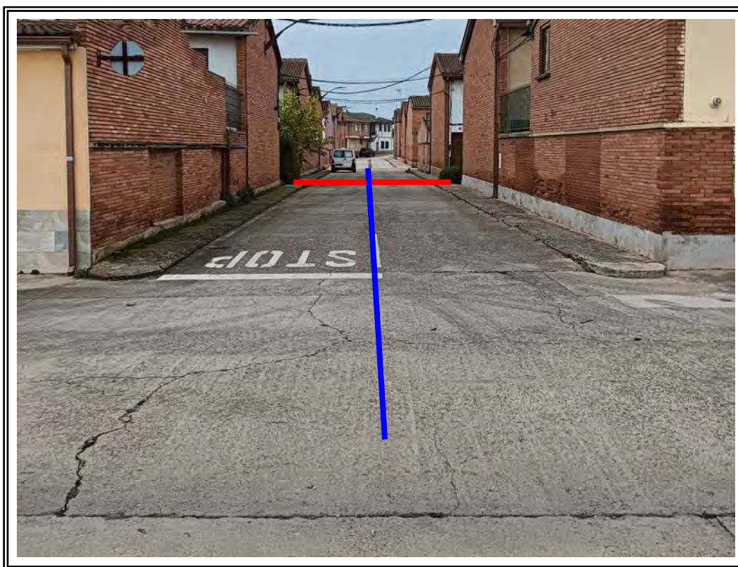
FOTO 16 – Vista de Este a Oeste
