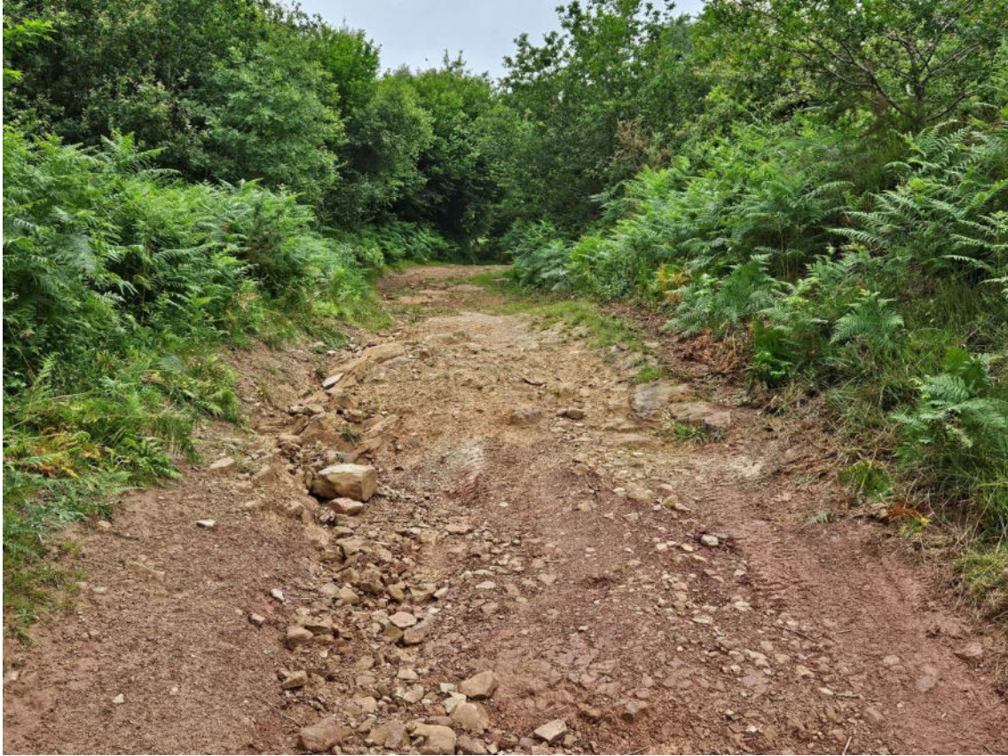
Fotografía donde se aprecia el mal estado de la explanación en Pista Lekaroz-Arakan
