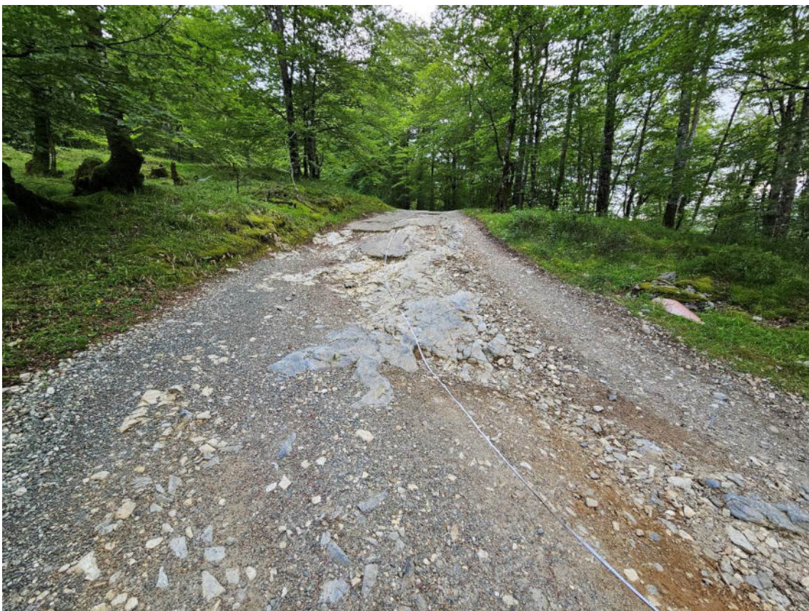
Estado actual del tramo a hormigonar en Pista Ariztizelaia.
