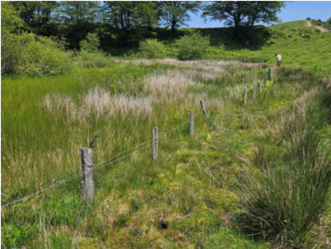
Fotografía de la balsa de Azaldegi donde se aprecia el mal estado del cierre en zona inundada
