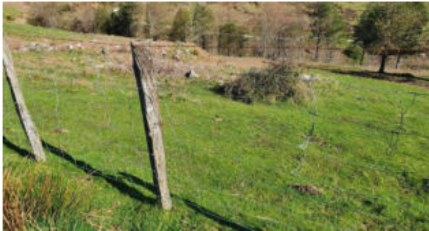
Estado actual de un punto del cierre de Lizartzu que precisa de reparación, se han deslizado los nudos de la malla.
