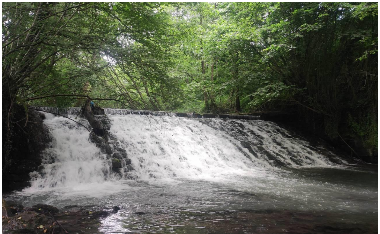
Figura 0: Presa o azud de Olaberria antes de su apertura.
