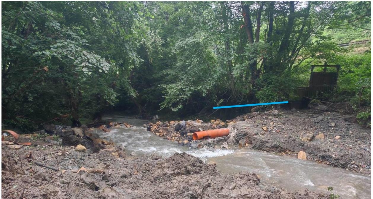
Figura 2: Colector unitario en el trasdós de la antigua presa de Olaberria. En azul, altura de la cota de coronación de la presa.
