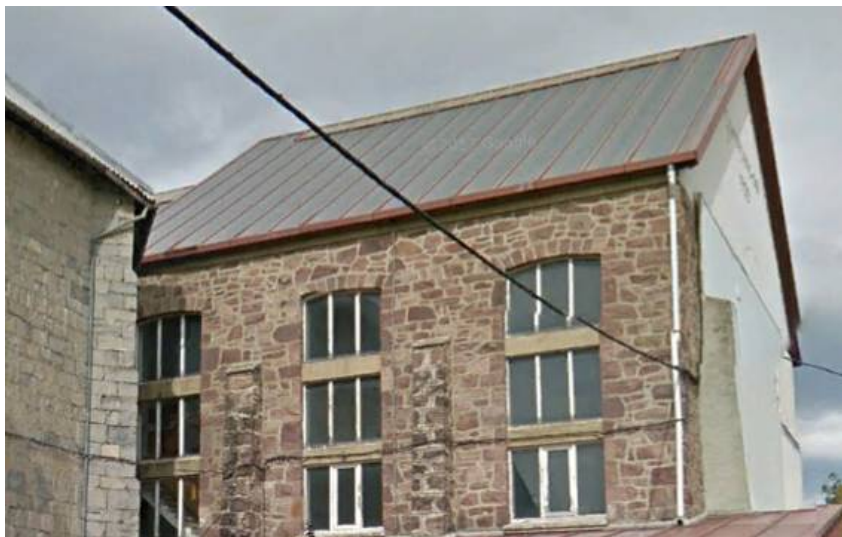
Cubierta de chapa con lucernario de cumbrera y canalones de chapa
