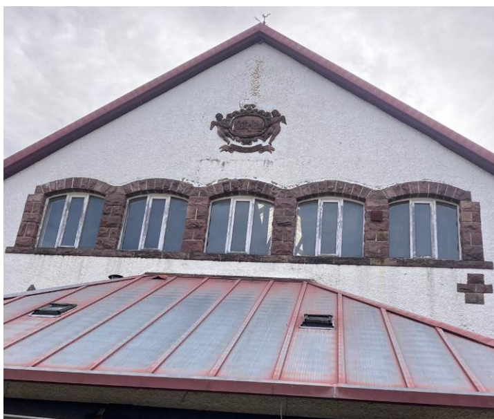
Ventanales fachada oeste
