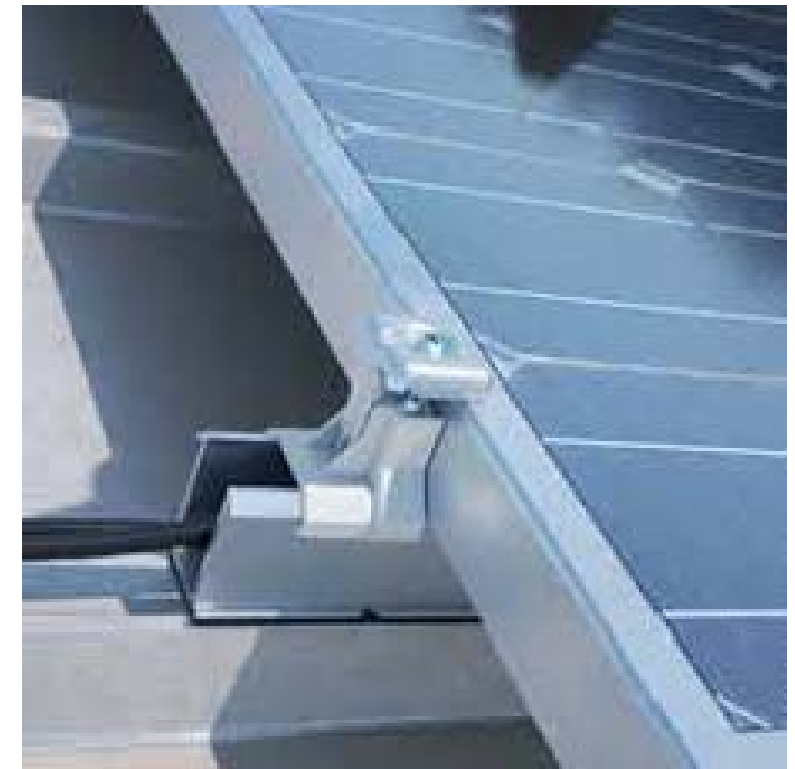
DETALLE SUJECIÓN PANEL CUBIERTA METÁLICA
