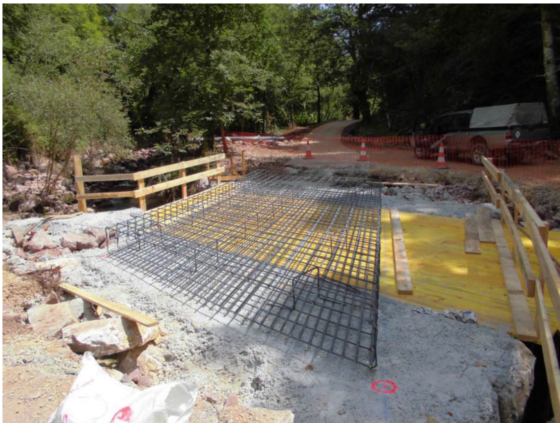
Foto de construcción de losa de hormigón del puente con armadura construido en un puente en 2014 en un camino cercano; y similar al que se va a construir.
