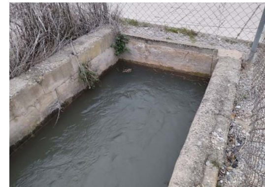
Vista de la acequia existente, aguas arriba de la calle Príncipe de Viana, donde se observa que va a sección llena
