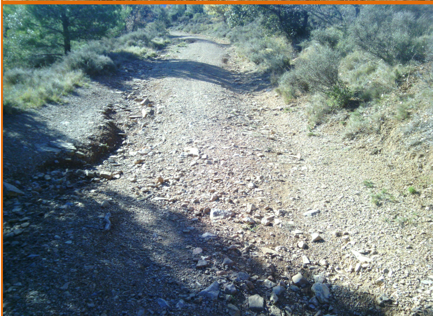
Foto 2. Detalle de los tramos objeto de construcción e cunetas e introducción de elementos drenantes en el camino de Rozaval-Chucarrada.
