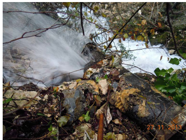
Figura 13: Rotura de tubería por caída de rocas año 2013
