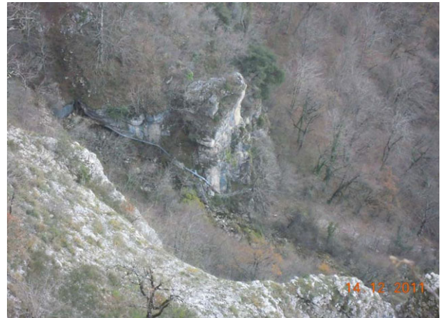
Figura 11: Vista de tubería desde parte superior del "Circo"
