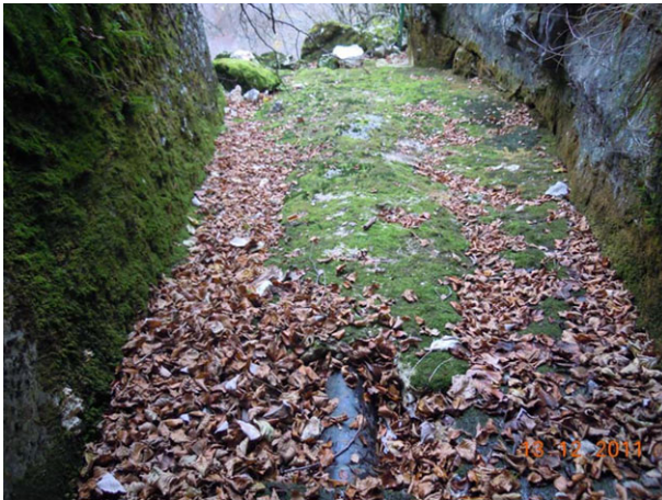
Figura 6: Salida de Arteria de la galería
