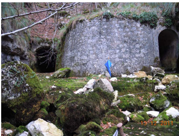
Figura 2: Entrada a galerías
