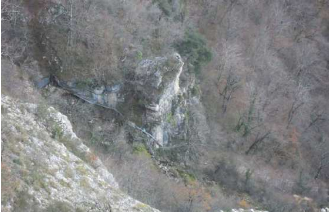
Vista de tubería desde la parte de arriba del circo. La tubería transcurre junto al roquedo
