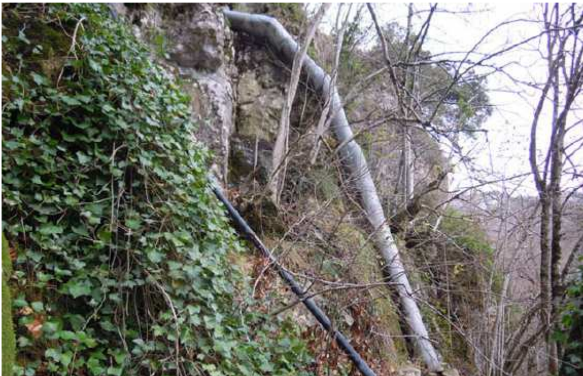
Tubería colgada en pared. En el área del proyecto hay también algunas hayas de pequeño porte y en las zonas más húmedas, las hiedras
