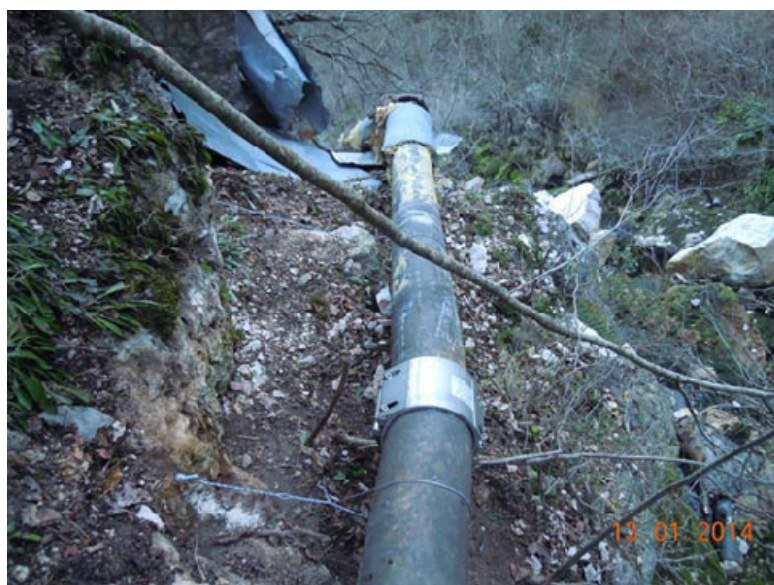
Figura 17: Reparación con abrazaderas
