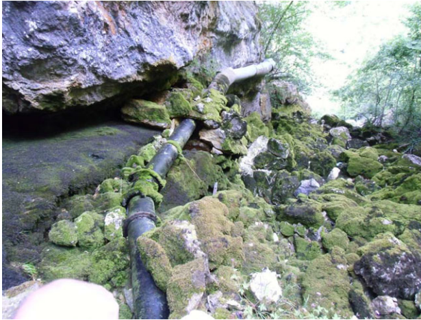
Figura 8: Tubería colgada en pared
