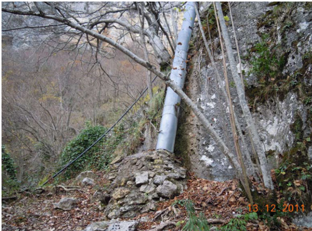
Figura 10: Punto donde la tubería se introduce bajo tierra
