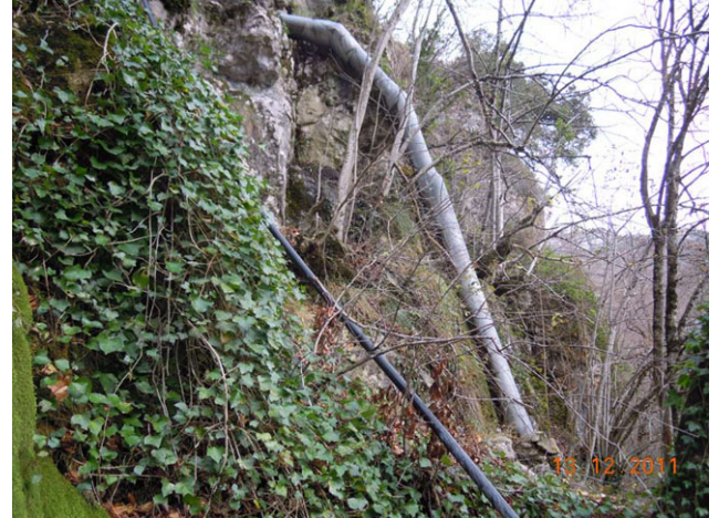
Figura 9: Tubería colgada en pared
