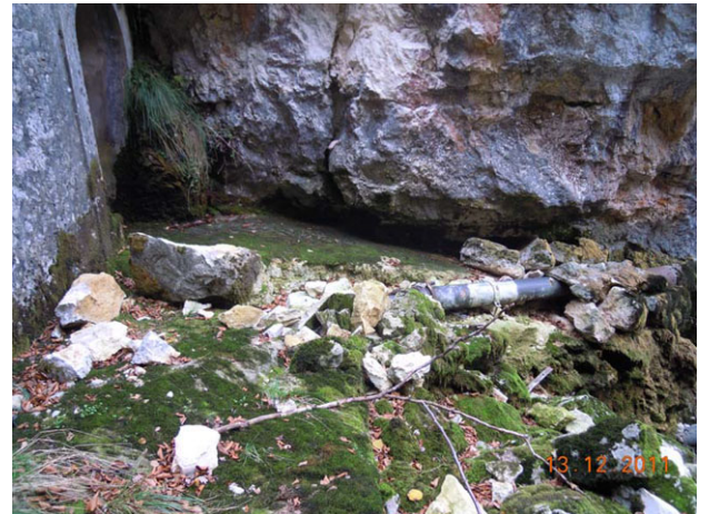
Figura 7: Salida de Arteria de la galería
