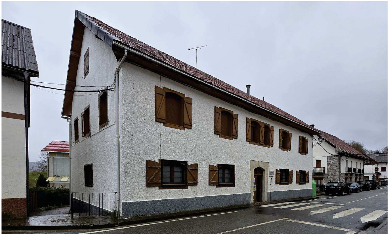
Imagen Alzado Norte del Edificio
