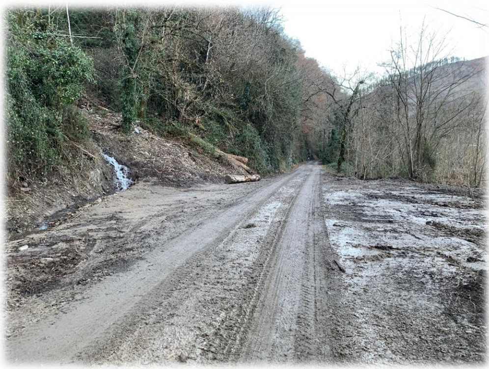
Fotografía 5: Vista general de la regata inmemorial en la zona de Bisusta, interceptada y desviada por la Vía Verde del Bidasoa
