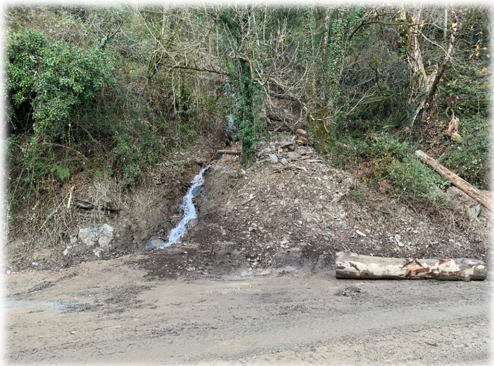
Fotografía 6: Vista general de la regata inmemorial en la zona de Bisusta, interceptada y desviada por la Vía Verde del Bidasoa
