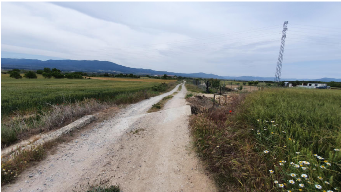
Fotografía donde se aprecia que el camino es estrecho para los camiones y con áridos artificiales. Zona llana
