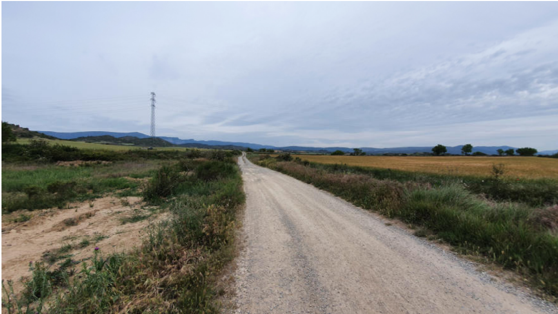
Fotografía donde se aprecia que el camino es estrecho para los camiones y con áridos artificiales escasos. Zona llana
