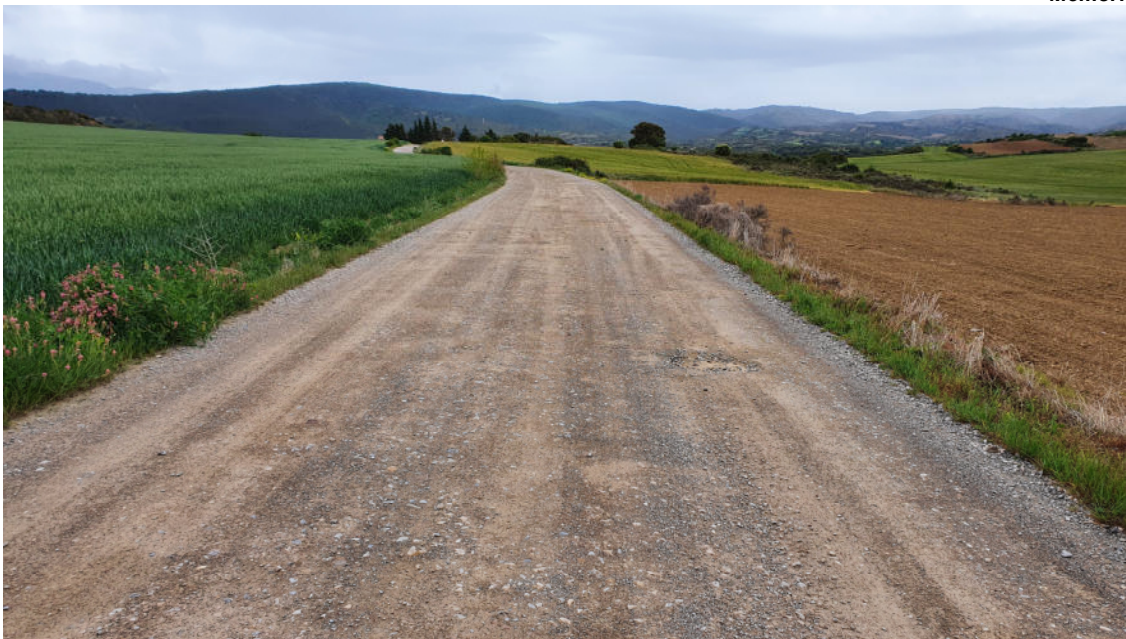
Otra fotografía donde se aprecia la existencia de baches y con áridos artificiales escasos. Zona llana
