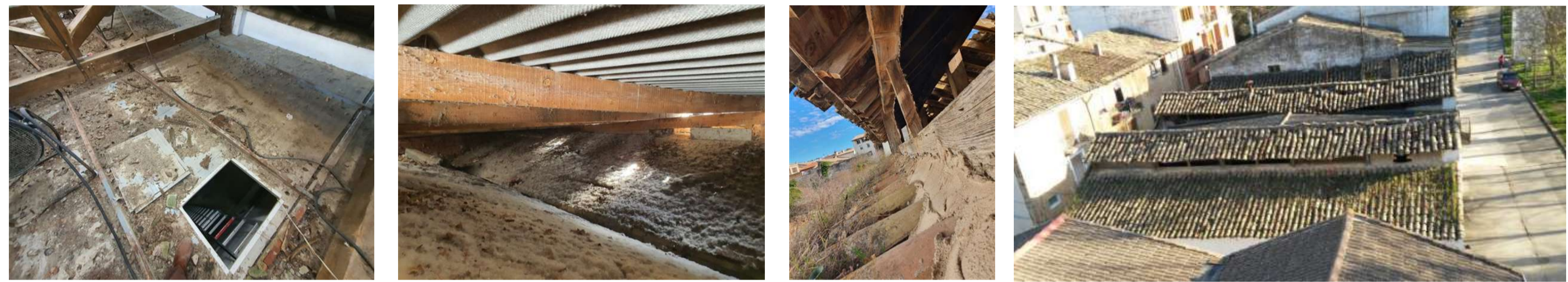
10- Trampilla de acceso a entrecubierta
