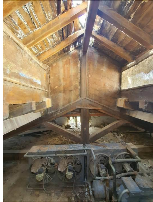
Cubierta norte, hacia el oeste.
