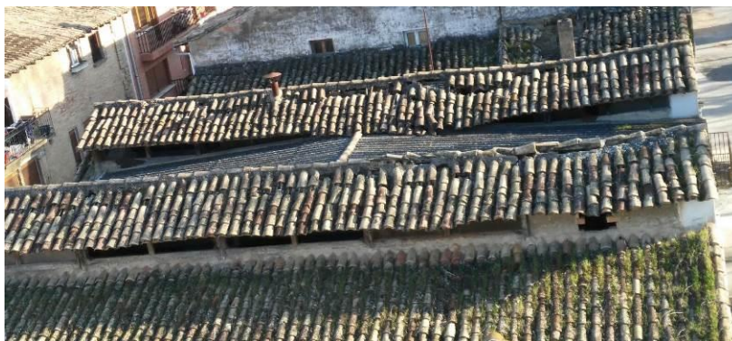
Estado de las cubiertas en 2017. Se puede observar la cubierta de uralita a dos aguas.
