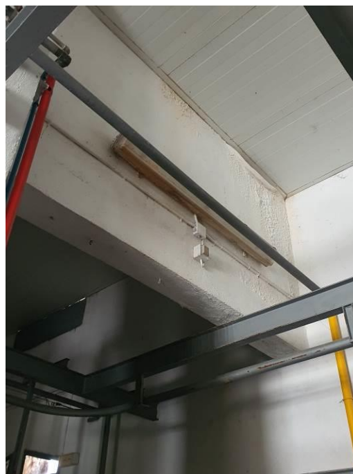
Aparente refuerzo del apoyo de la cercha sobre el muro Presencia de humedades en la fachada norte.
