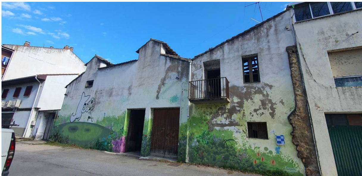
Fachada Oeste modificada, con la cubierta de uralita asomando entre las linternas.
