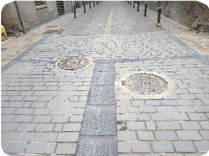
F1 Hundimiento tapas D600mm inicio calle
