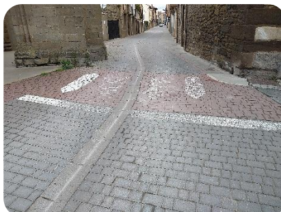
F14 Fallos en rodadura en giros y frenada.
