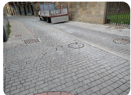
F9 Fallos en adoquín y tapas asociado a giros
