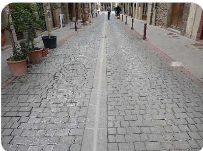
F7 Hundimiento asociado a rodadura
