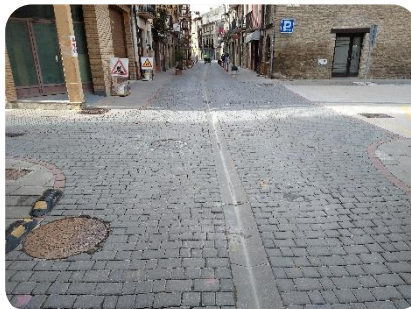
F5 Fallos en adoquín y tapas asociado a giros
