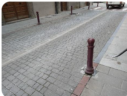
F8 Colocación y posición actual pilonas fijas
