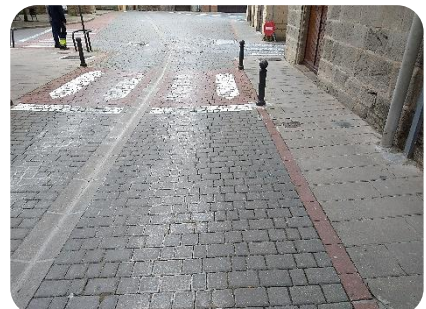
F12 Fallos en rodadura en giros y frenada.
