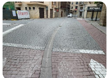
F15 Fallos en rodadura en giros y frenada.
