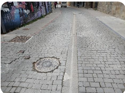
F10 Fallos en adoquín y tapas asociado a giros
