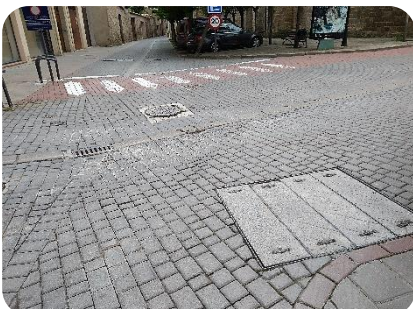
F13 Fallos en rodadura en giros y frenada.
