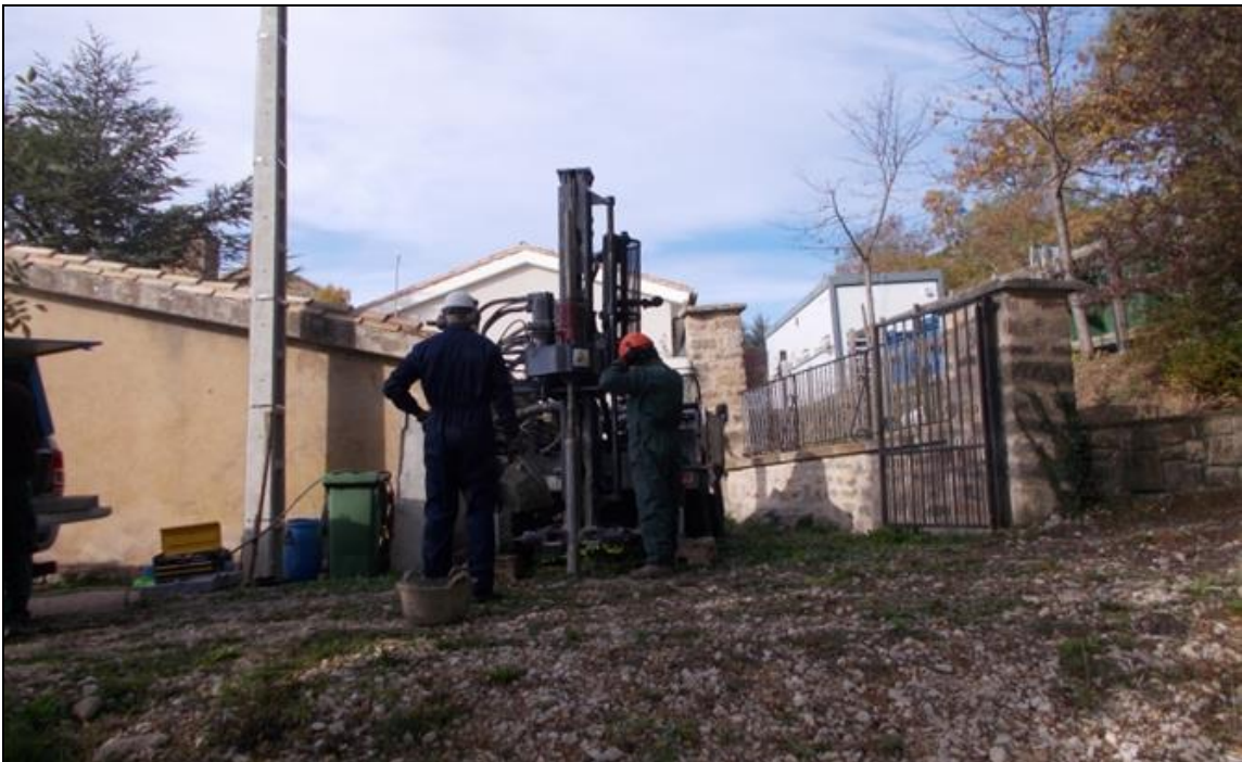
Fotografía 4. Realización del sondeo mecánico (vista hacia el oeste).
