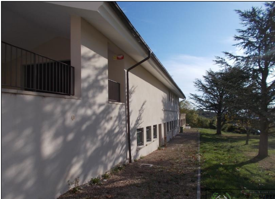
Fotografía 2. Vista de la zona sur del edificio Recepción de Visitantes (vista hacia el este).
