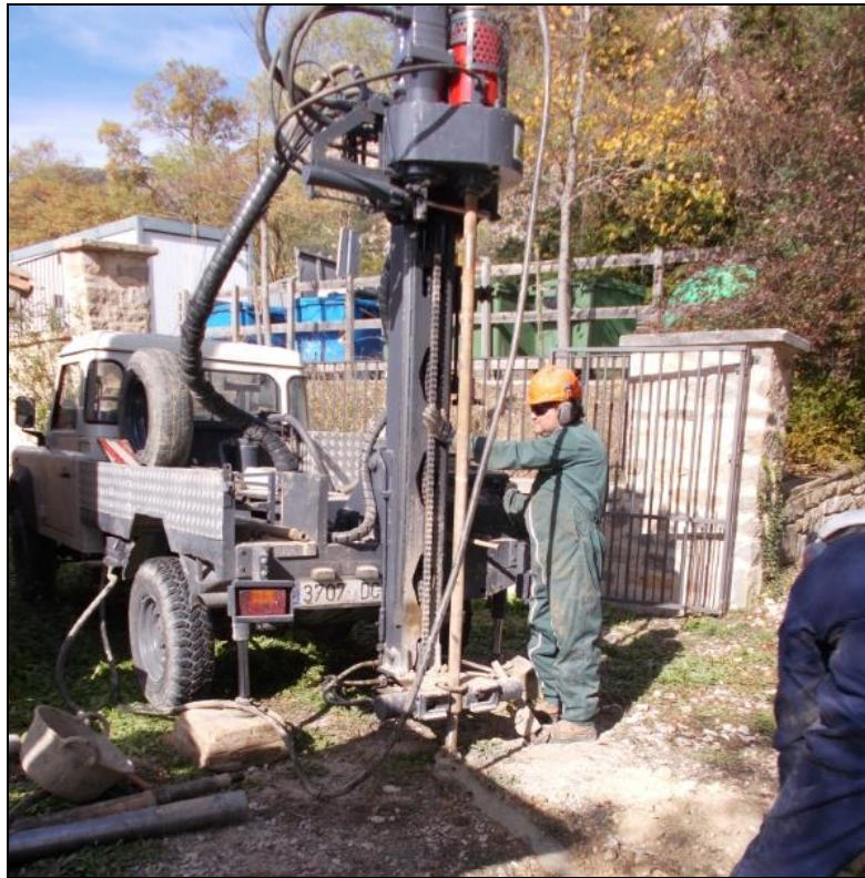
Fotografía 5. Realización del sondeo mecánico (vista hacia el oeste).
