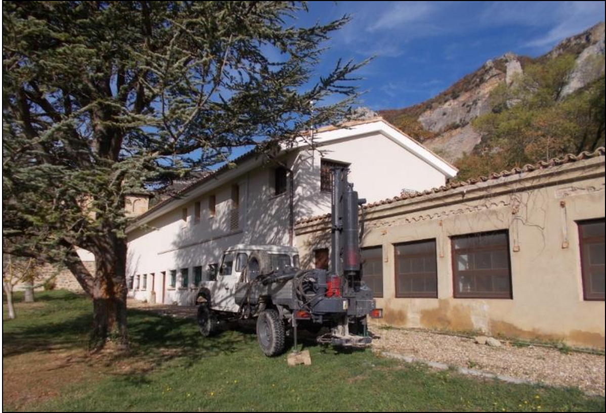
Fotografía 7. Realización del ensayo DPSH P-2 (vista hacia el oeste).
