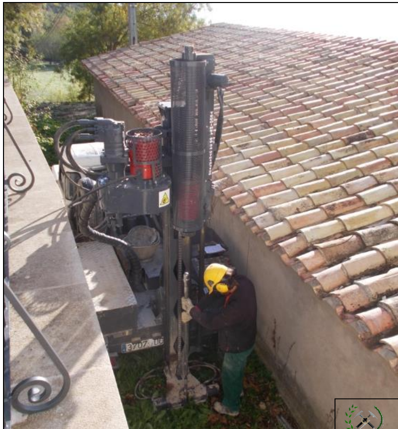
Fotografía 6. Realización del ensayo DPSH P-1 (vista hacia el este).
