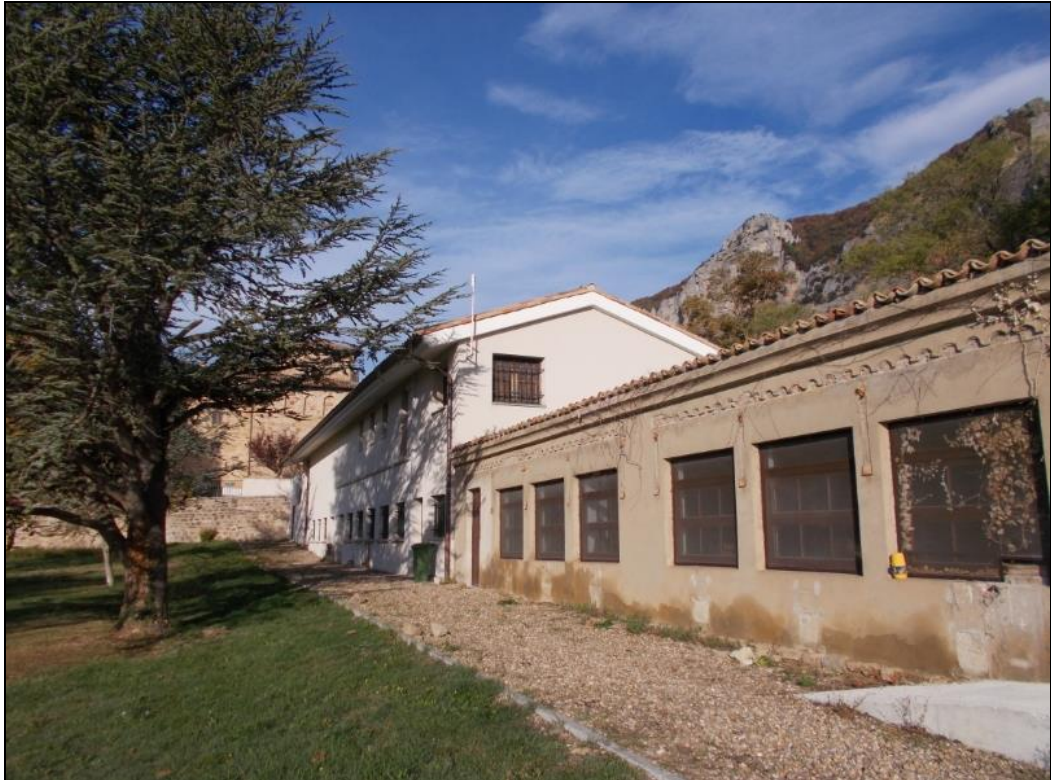
Fotografía 1. Estado de la zona prevista para la ampliación en el momento del estudio (vista hacia el oeste).
