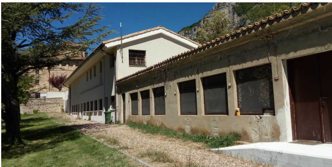
Vista de los alzados meridionales de los edificios objeto de la actuación desde la zona ajardinada. Al fondo, el edificio principal. En primer plano, el edificio auxiliar
