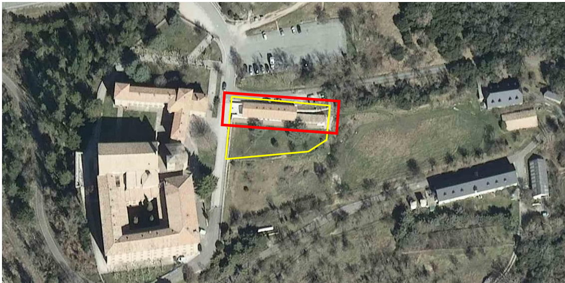
Ortofoto aérea del Monasterio de Leire. En amarillo, ámbito de actuación del proyecto; en rojo, edificios en los que se interviene
