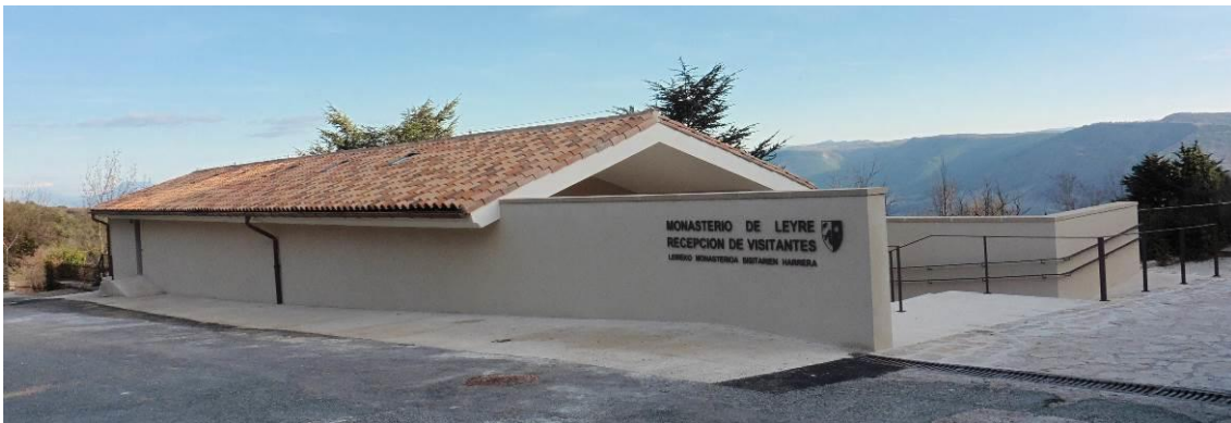
Alzado norte del edificio principal en cuya planta primera se sitúa la recepción de visitantes
