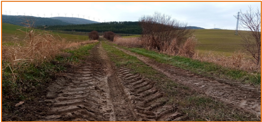
Ilustración 11: Tramo de Camino Celigueta-Muguetajarra con cuneta colmatada de material
