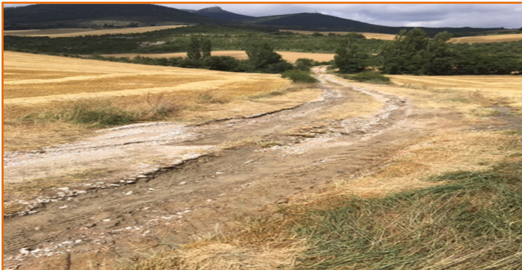
Ilustración 6: Detalle del estado tras la tormenta del camino de la Junquera
