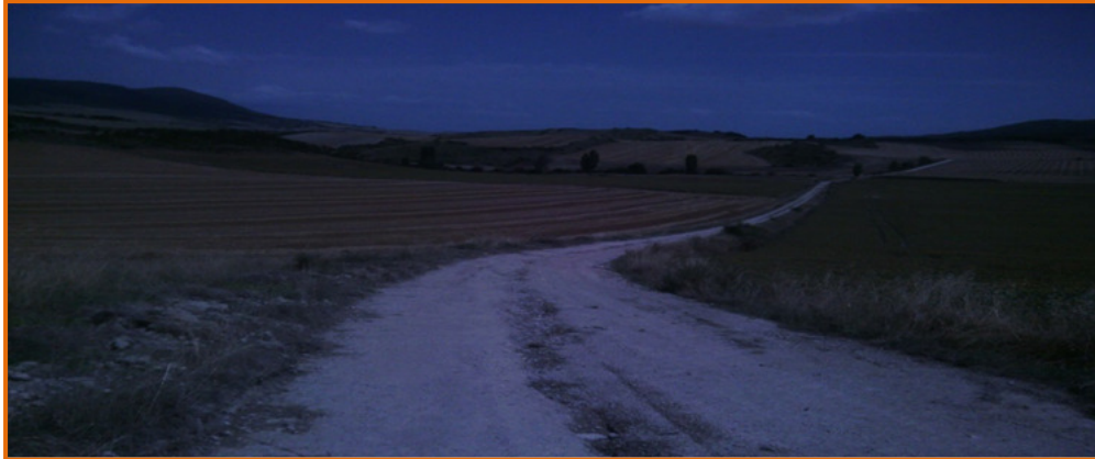
Ilustración 3: Detalle de tramo de Camino Las Bordas tras tormenta
