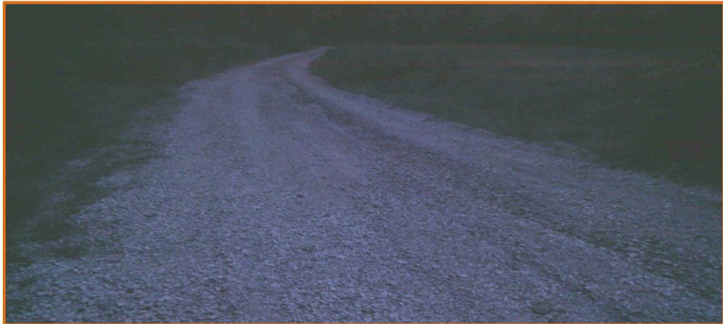
Ilustración 9: Detalle del tramo de lavado de material por escorrentía
