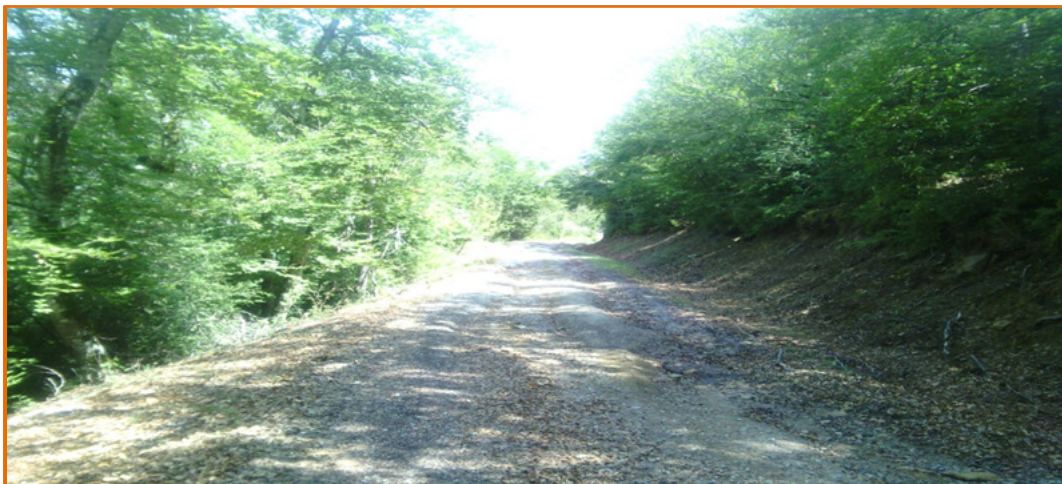
Ilustración 8: Detalle del estado actual del tramo alto del camino de la Sierra
