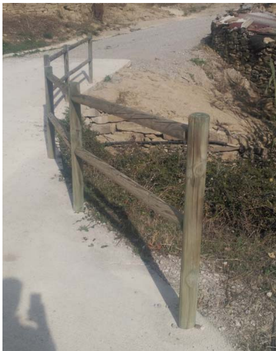
Imagen del puente que atraviesa el barranco. Fin del trazado del vallado propuesto.
