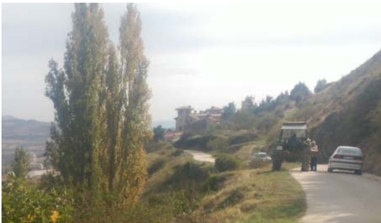
Vista general del camino hormigonado en el cual se propone colocar el vallado de protección. Muy utilizado por vehículos agrícolas.
