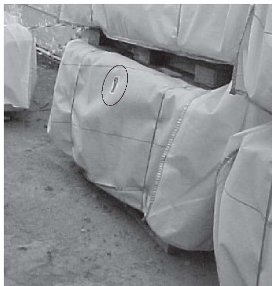
. Big-bags para placas de fibrocemento con amianto y detalle de señalización
