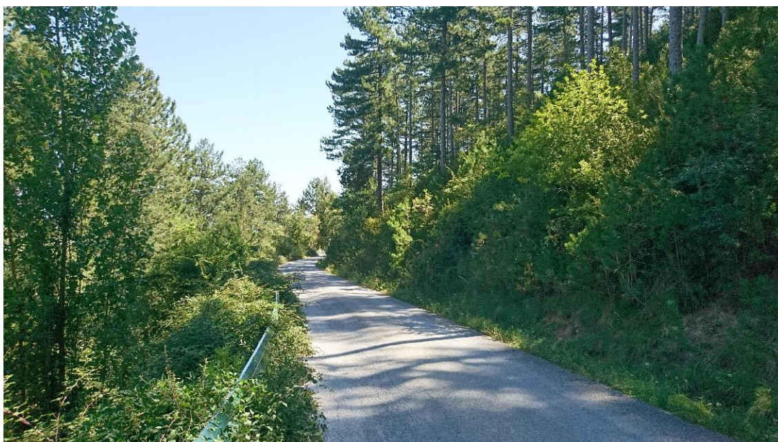
Fotografía del estado actual Camino de la Plana, donde se aprecia la necesidad de desbroces.
