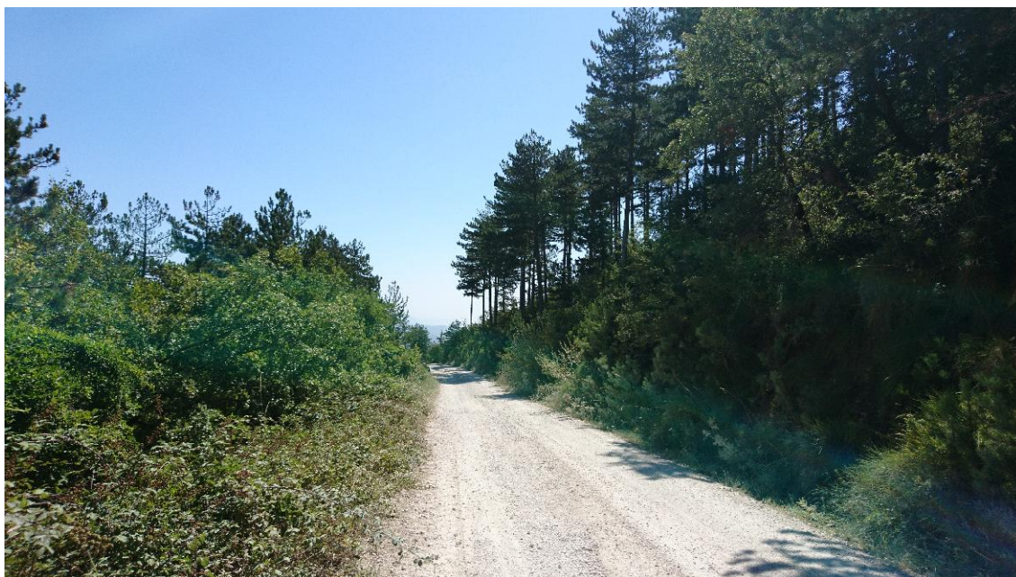
Otra fotografía del estado actual de la capa de rodadura del Camino de la Plana
