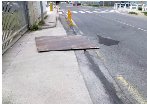
Detalle de relleno de zanja con mortero de hormigón coloreado.
