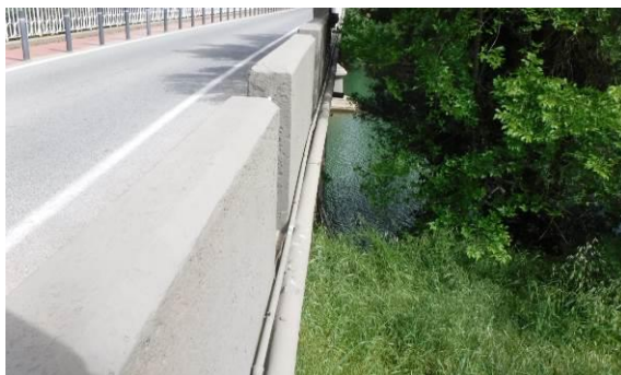
Puente de Liédena
