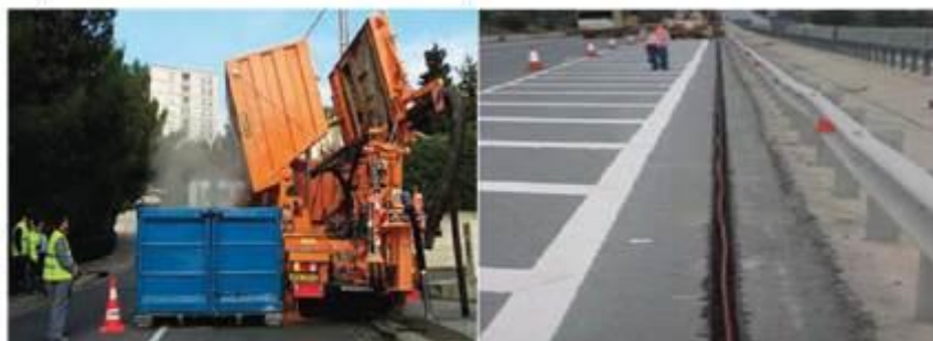
Detalle de vertido de residuos y de tendido de tritubo en microzanja.
