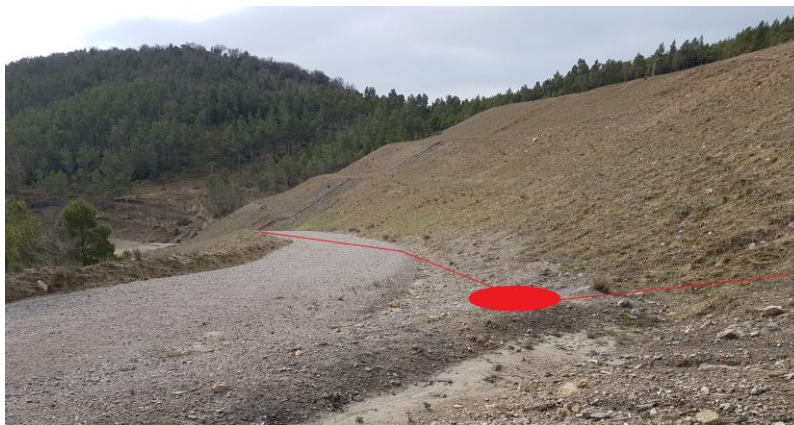
Arqueta 6 en la que se abandona el camino de servicio
